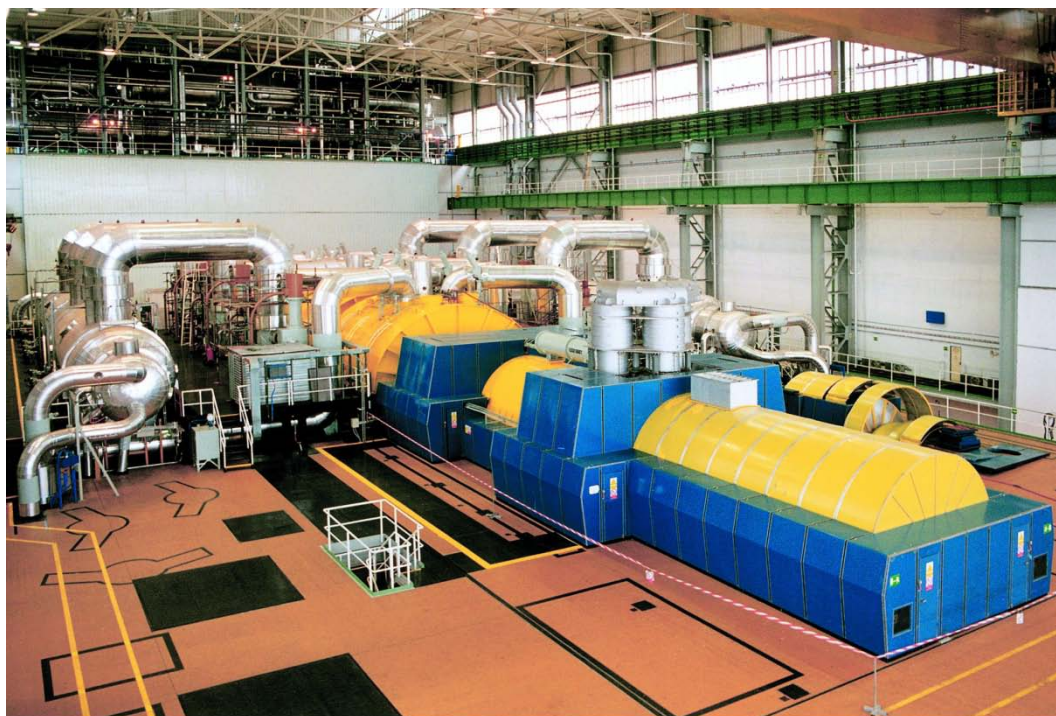
Obrázek 4.1 Vícetělesová parní turbína Jaderné elektrárny Temelín[3]
