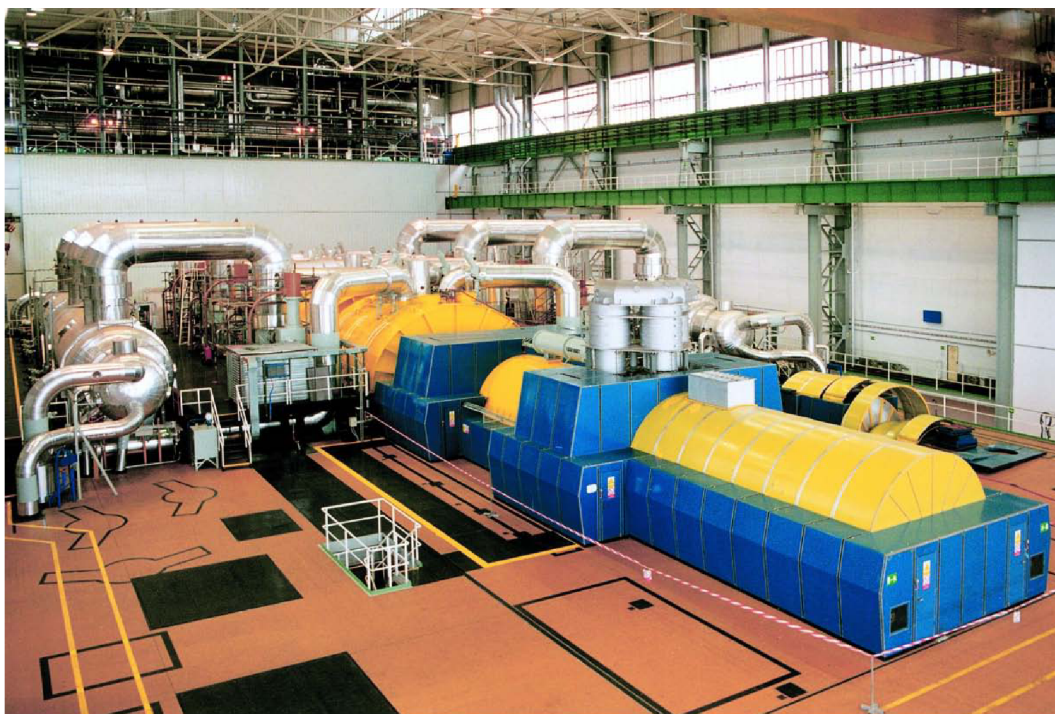
Obrázek 4.1 Vícetělesová parní turbína Jaderné elektrárny Temelín[3]
