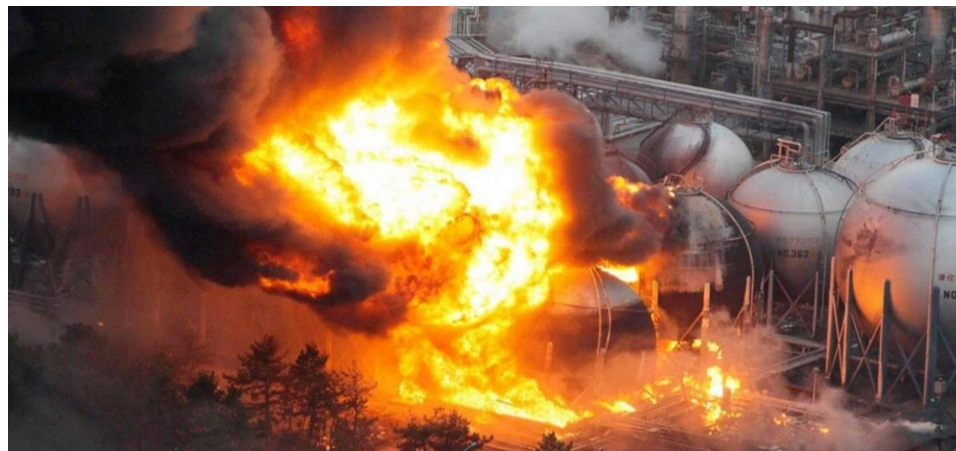
Obrázek č. 4: Výbuch v elektrárně Fukušima (Japonsko) - 2011 53
