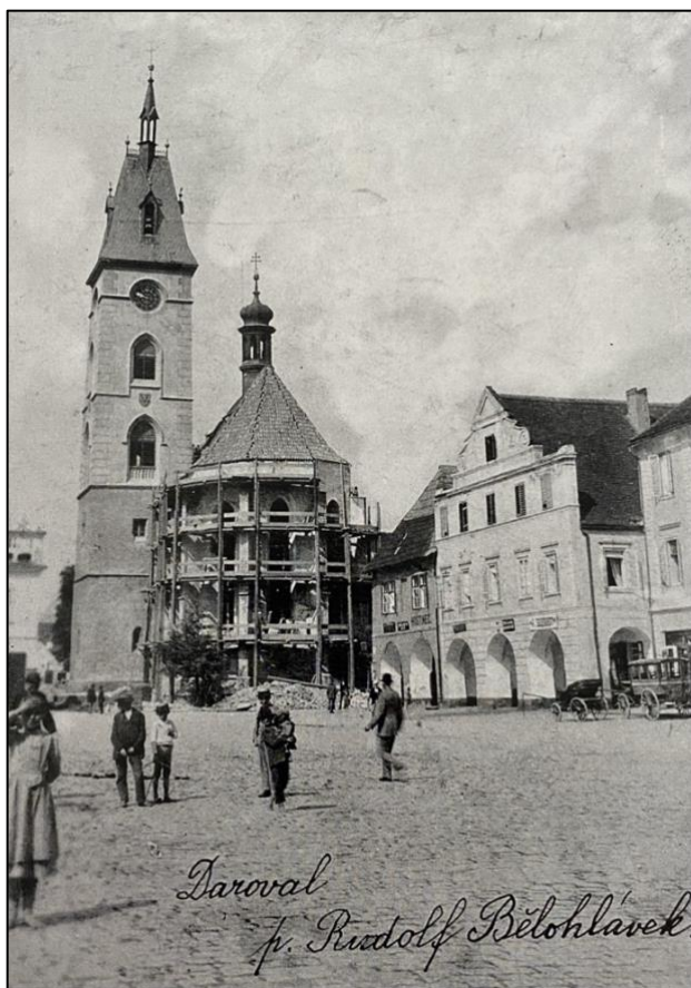
11. Kostel během novogotické přestavby – východní průčelí.
