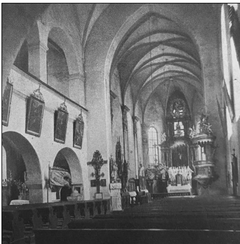
8. Interiér kostela před regotizací (před rokem 1895), pohled na presbytář z hlavní lodi, fotografie.
