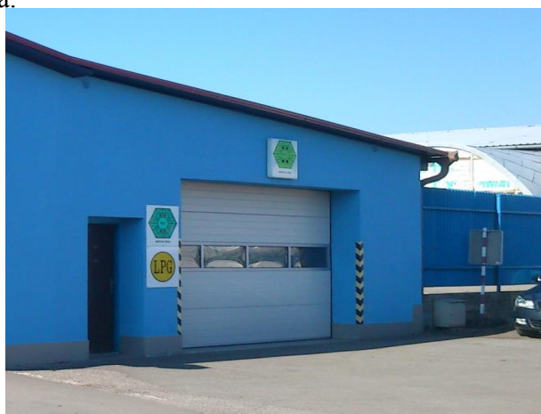
Obrázek 9 Stanice měření emisí
