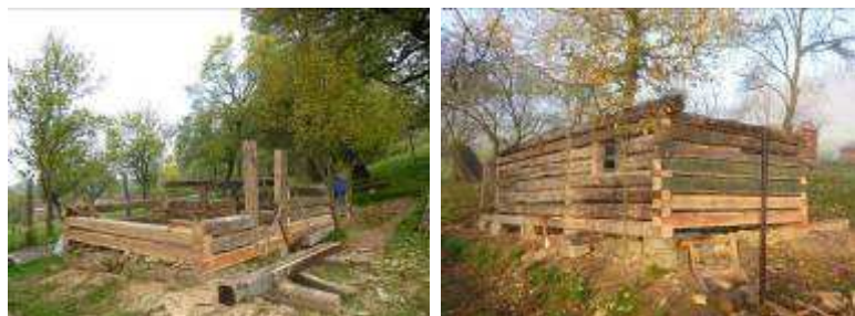
Vlachovice. Pohled na nové místo a rekonstrukci Doruškovy sušárny. Říjen 2013. Foto R. Fryzelka.
