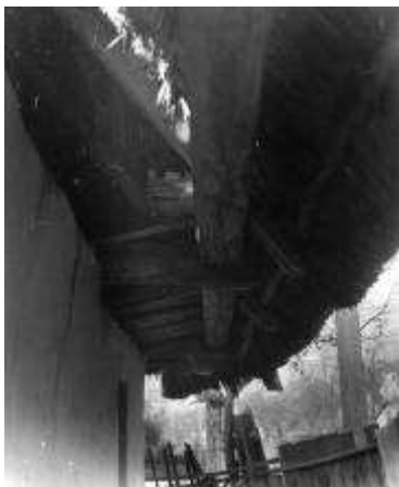
Nosná trámová konstrukce vystupující nad násyp v šířce asi 65 cm. Na hlavních trámech jsou zapuštěny krokve. Obytný dům č. p. 69. Foto J. Pešek, r. 1967.
