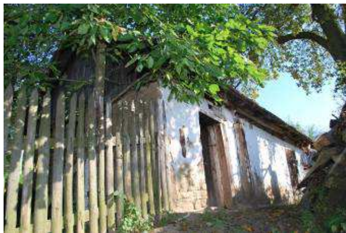
Funkční sušárna u č. p. 74, pohled na vstup do sušárny. Zbytky vápenné omítky patrné jen na pření části u vstupu do objektu. Zlámanec. Foto A. Korčáková, r. 2011.
