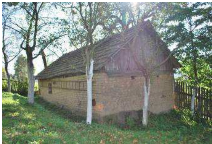
Funkční sušárna u č. p. 74, pohled na stěny sušárny - režné nepálené cihly a dřevěný štít. Zlámanec, foto A. Korčáková, r. 2011.
