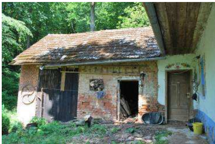
Obytný dům č. p. 307, pohled na část přístavby, r. 2010. Foto A. Korčáková.
