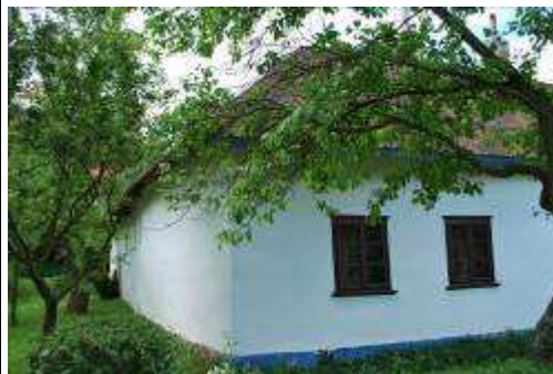
Vlevo obytný dům č. p. 11 – detail hliněné stěny s modrou podrovnávkou, valbové střechy s dřevěnými okny, vpravo detail řemeslně zhotovených dveří s dřevořezbou. Foto A. Korčáková, r. 2011.
