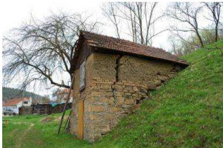
Sklep u domu č. p. 18 Přečkovice, foto A. Korčáková, r. 2011.
