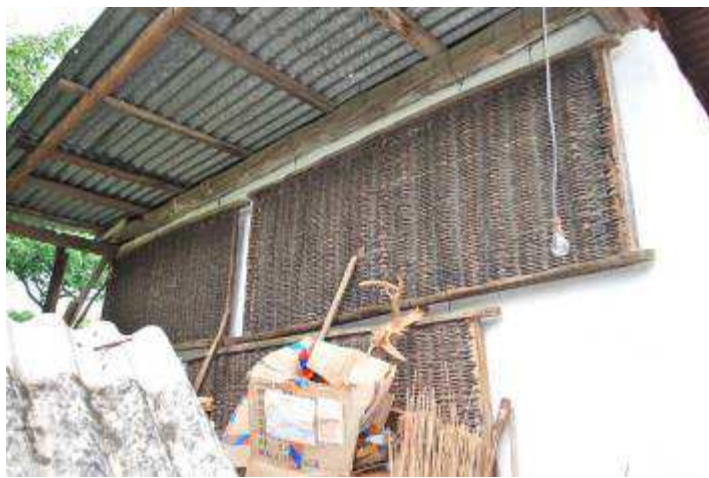
Sušárna Drslavice u č. p. 24, nahoře pohled na polootevřenou komoru (neboli tzv. předsíň, vyjdanek) a vysouvací lésy. Foto A. Korčáková, r. 2010.
