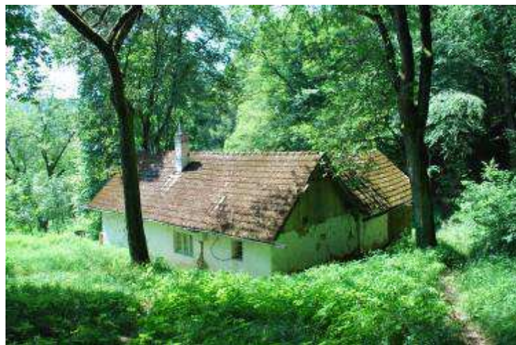
Obytný dům č. p. 307, pohled na původní hliněnou část s komínem a nově navazujícím traktem, r. 2010. Foto A. Korčáková.
