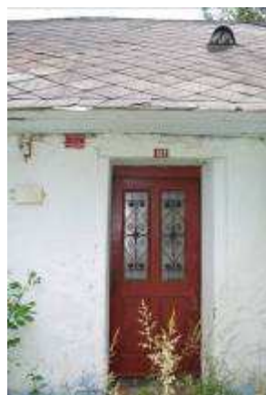
Vlevo obytný dům č. p. 132, detail hliněné stěny, dřevěného podbití a modré podrovnávky, vpravo detail dveří a střechy s eternitovou krytinou. Foto A. Korčáková, r. 2011.
