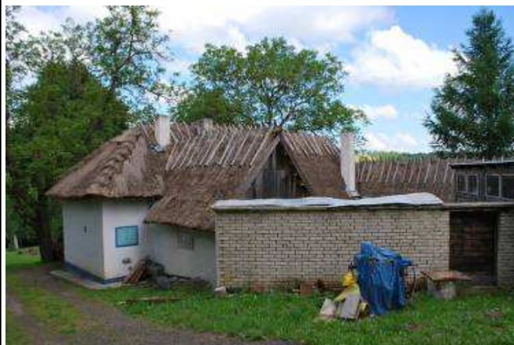
Obytný dům č. p. 141, pohled na zadní trakt domu, r. 2010. Foto A. Korčáková.
