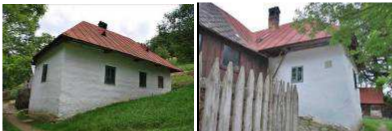
Dům č. p. 68. Pohled na obytnou a hospodářskou část. Obytná část je z nabíjené hlíny na kamenných základech s dřevěnými stropy. Okna jsou kastlová. Na část obytnou kolmo navazují chlévy kryté dřevěným podsíňkem. Střecha je valbová, plechová na části obytného objektu, z části je pak z osinkocementových šablon. Foto A. Korčáková, r. 2010.
