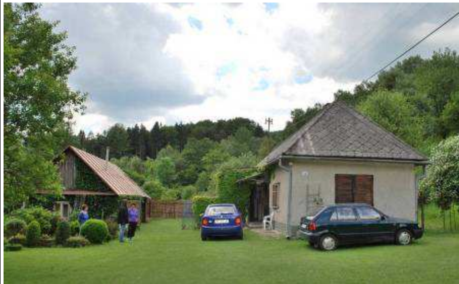
Obytný dům č. p. 118, pohled na nově postavený dům, r. 2010. Foto A. Korčáková.
