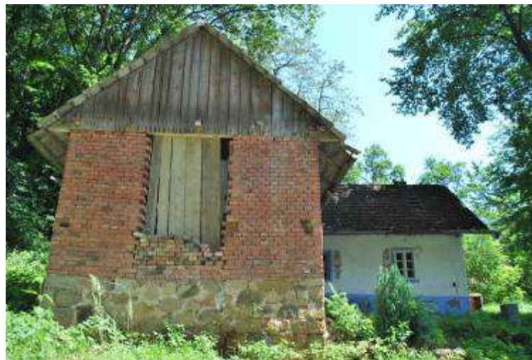
Obytný dům č. p. 307, pohled na štít přístavby, r. 2010. Foto A. Korčáková.
