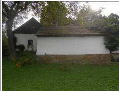
Dům č. p. 24. Pohled na hospodářskou a obytnou část. Objekt na půdorysu tvaru L doplněn menší nízkou hospodářskou samostatnou budovou s kamennou podezdívkou. Obytná část je z novějších materiálů, vápenocementová omítka. V průčelí domu modrá podrovnávka, modré lemování kolem oken. Dřevěný trakt původní hospodářské usedlosti renovován. Na objektu je vidět dobrá řemeslná práce v detailu – uložení kamene. Dům je citlivě zasazen do prostředí. Foto A. Korčáková, r. 2013.
