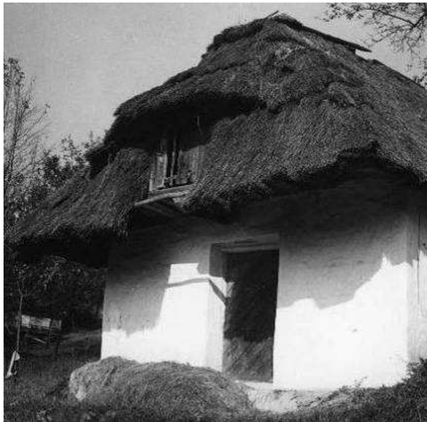
Vinohradnická stavba ve Veletinách s doškovou střechou. Pravděpodobně st. 160. Autor foto V. Frolec, r. 1965.
