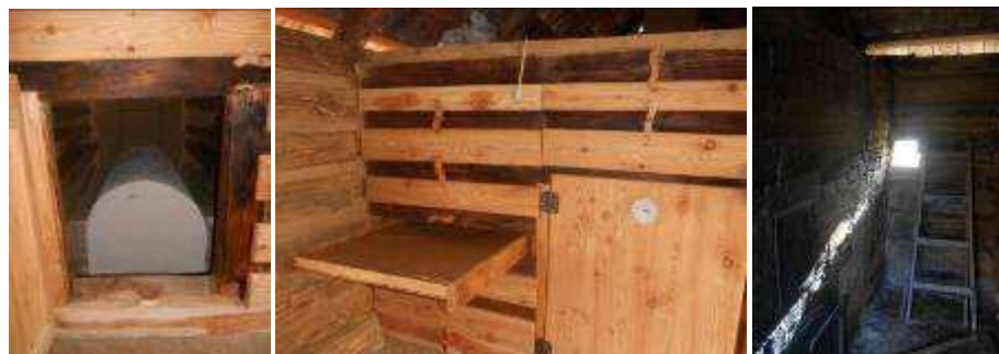
Doruškova sušárna – zrekonstruovaná Sušárna sv. Františka. Vpravo nahoře detail štítu a konstrukce, vlevo dole detail prostoru uvnitř sušící komory s pecí a lésami, dole uprostřed detail manipulačního prostoru „přebíračky“ s vysouvacími lésami, dole vpravo pohled do síňky a na prostor přikládání do pece. 19. 1. 2013. Foto A. Korčáková.
