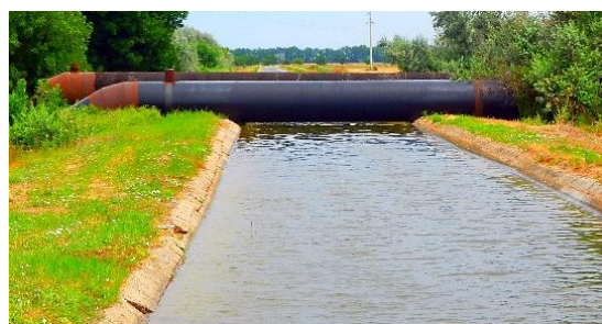
Obr. 3.35. Přemostění prvního a druhého řadu přivaděče přes zavlažovací kanál P-4-2
