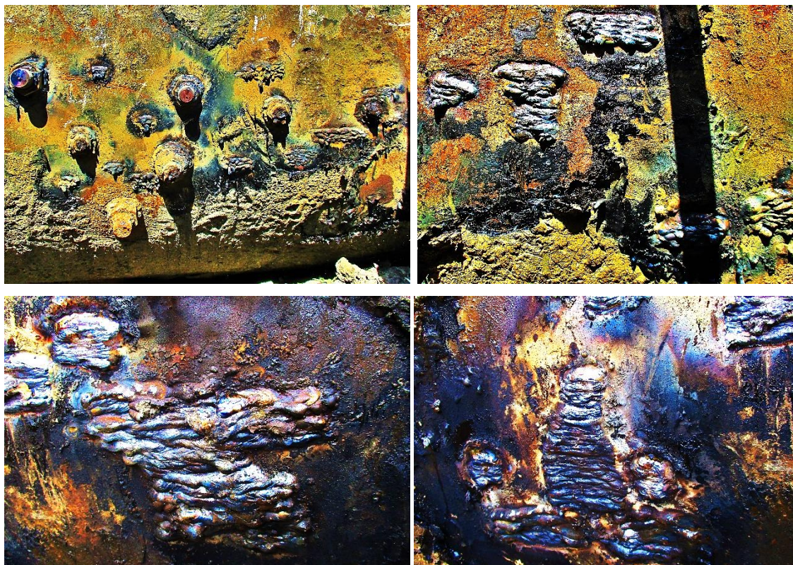
Obr. 3.124, 3.125, 3.126 a 3.127. Zatavení obalenou elektrodou míst, kde můžou vznikat fistuly na úseku potrubí délky 300 m prvního řadu přivaděče Dnipro-Mykolajiv u vesnic Myrné [2]
