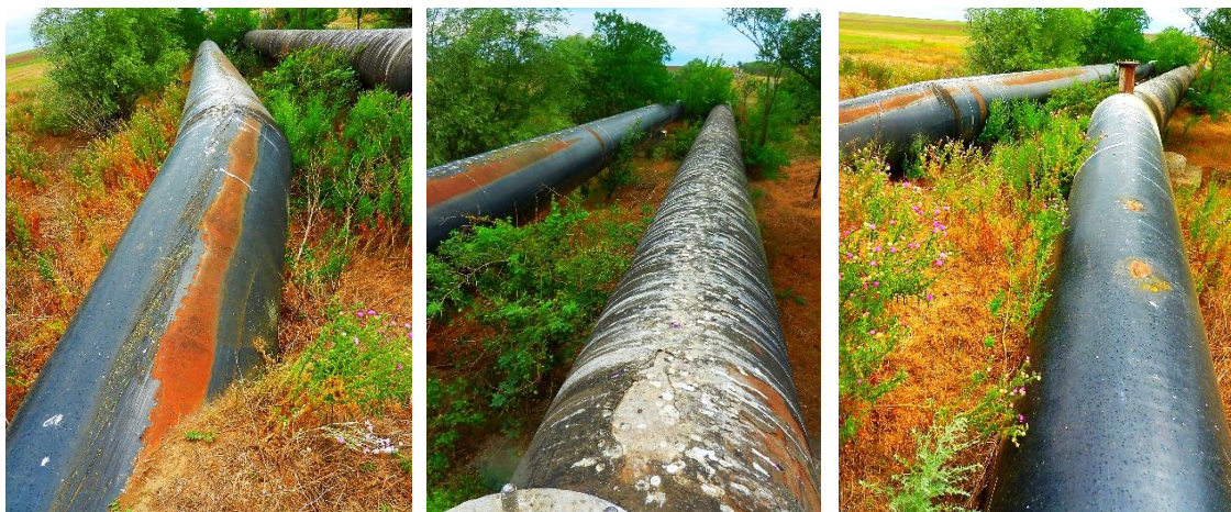
Obr. 3.37, 3.38 a 3.39. Přemostění druhého a prvního řadu přivaděče Dnipro-Mykolajiv přes Bilozerskou úžlabinu
