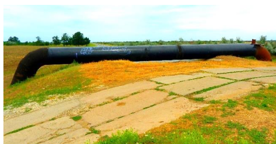
Obr. 3.36. Přemostění druhého řadu přivaděče přes zavlažovací kanál P-9
