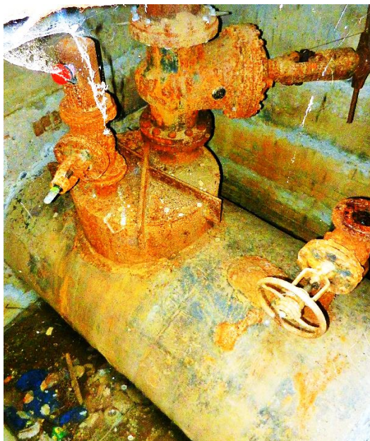
Obr. 3.66. Vzdušník DN 100 v šachtě č. M1 na druhém řadu přivaděče
