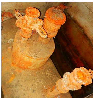
Obr. 3.97. Absence vzdušníku ve vzdušnikové šachtě č. E2' na druhém řadu přivaděče
