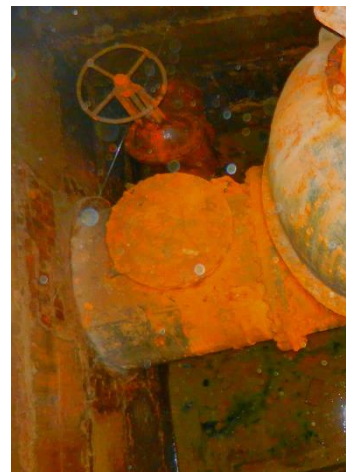
Obr. 3.70. Vstupní otvor v armaturní šachtě č. 63 na prvním řadu přivaděče
