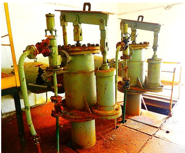
Obr. 3.24 a 3.25. Automatické tlumiče tlakových rázů typu ГY-350 na druhém řadu přivaděče
