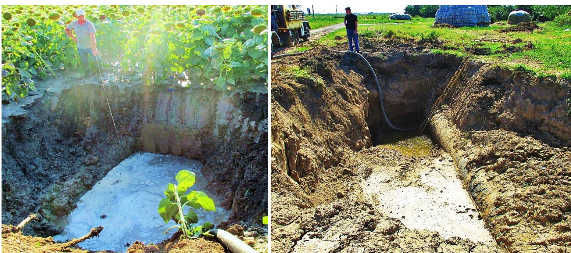
Obr. 3.76 a 3.77. Likvidace úniků vody 27. 7. 2018 na prvním řadu přivaděče Dnipro-Mykolajiv na úsecích v okolí vesnice Myrné a 03. 8. 2019 v okolí vesnice Ševčenkové [2]
