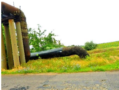
Obr. 3.30. Druhý řad přivaděče se kříží s železnicí Cherson-Mykolajiv a silnici E-58, M-14, P-47 u předměstí města Cherson podchodem. Za silnicí podchod přechází v přemostění přes žlab dešťové kanalizace
