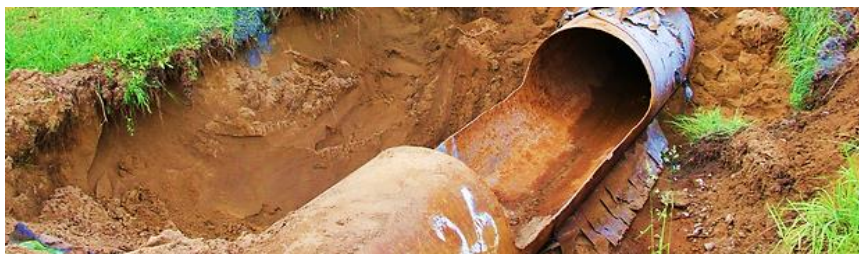
Obr. 3.141. Výkop na počátku opravovaného úseku a výřez potrubí [26]
