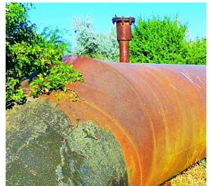
Obr. 3.101. Absence vzdušníku Ж2' na přemostění prvního řadu přivaděče přes zavlažovací kanál P-11
