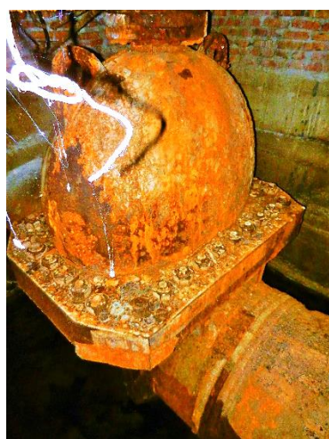
Obr. 3.47, 3.48 a 3.49. Sekční kovovětšníci ocelové šoupátko DN 1 000 se stoupajícím vřetenem s elektrickým servomotorem v armaturní šachtě č. 13 na prvním řadu přivaděče u zvyšovací stanice Cherson
