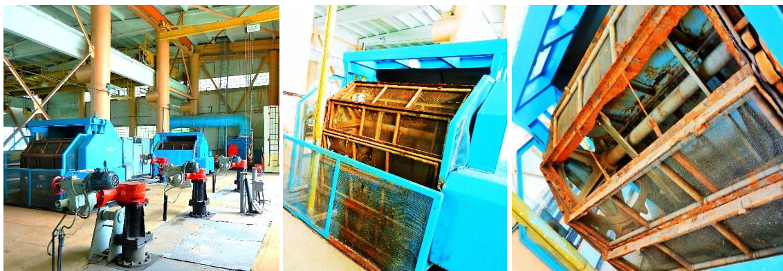
Obr. 3.4, 3.5 a 3.6. Havarijní samočisticí česle TH-2000
