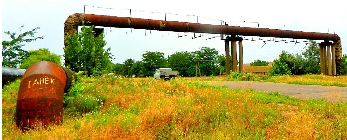
Obr. 3.27. Technologický nadchod druhého řadu nad prvním řadem u města Cherson
