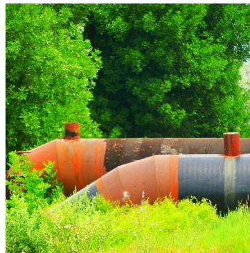
Obr. 3.100. Absence vzdušníků č. П1 a П2 na přemostění prvního a druhého řadu přivaděče přes zavlažovací kanál P-4-2
