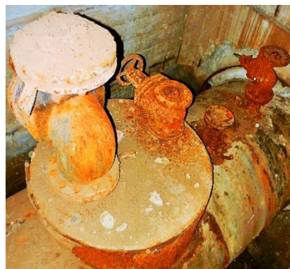
Obr. 3.98. Absence vzdušníku ve vzdušnikové šachtě č. A2' na druhém řadu přivaděče
