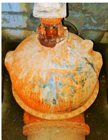
Obr. 3.44. Sekční kovovětšníci litinové šoupátko DN 1 200 s nestoupajícím vřetenem v armaturní šachtě č. 10 na druhém řadu přivaděče Obr. 3.45. Sekční kovovětšníci litinové šoupátko DN 1 200 s nestoupajícím vřetenem v armaturní šachtě č. 16 na prvním řadu přivaděče Obr. 3.46. Sekční kovovětšníci litinové šoupátko DN 1 200 s nestoupajícím vřetenem v armaturní šachtě č. 34 na prvním řadu přivaděče
