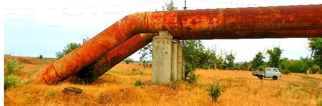
Obr. 3.32, 3.33 a 3.34. Přemostění prvního a druhého řadu přivaděče Dnipro-Mykolajiv přes bývalou řeku Věrevčyná
