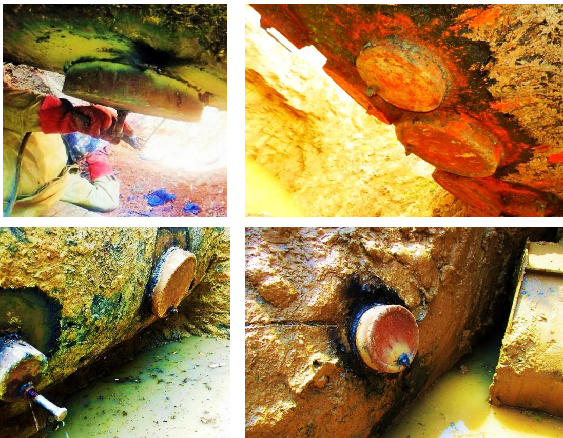
Obr. 3.116, 3.117, 3.118 a 3.119. Opravy úseku prvního řadu přivaděče Dnipro-Mykolajiv u vesnice Myrné pomocí přivařování tzv. „kastroľů“ k tělesu potrubí
