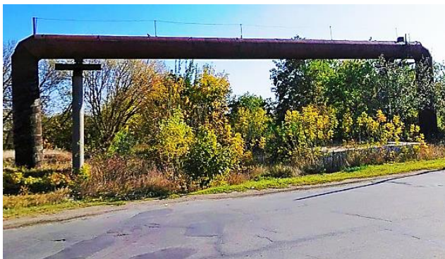
Obr. 3.26. Přemostění prvního řadu přivaděče přes bývalou železnici u města Cherson
