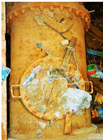
Obr. 3.69. Vstupní otvor v armaturní šachtě č. 30 na prvním řadu přivaděče
