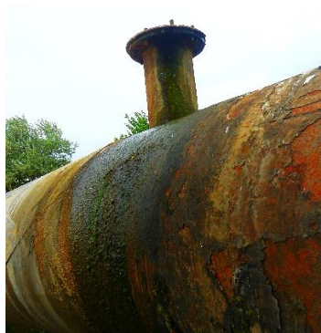
Obr. 3.99. Absence vzdušníku č. A2' na přemostění prvního řadu přivaděče přes Bilozerskou úžlabinu
