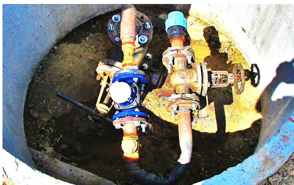
Obr. 3.71. Přípojka DN 100 soukromého farmářského podniku Artemová k prvnímu řadu přivaděče u vesnice Sadové
