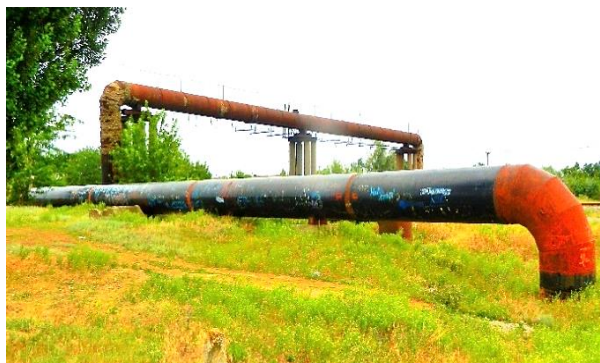
Obr. 3.31. Přemostění druhého řadu přes žlab dešťové kanalizace. Vzadu je vidět přemostění prvního řadu přes železnici Cherson-Mykolajiv a přes silnici E-58, M-14, P-47
