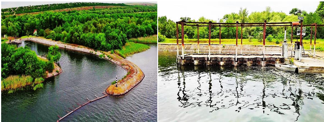
Obr. 3.2. a 3.3. Přívodní kanál a jímadlo na dně kanálu
