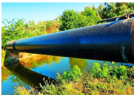
Obr. 3.40. Přemostění druhého řadu přivaděče přes zavlažovací kanál P-11
