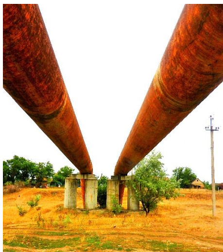
Obr. 3.32, 3.33 a 3.34. Přemostění prvního a druhého řadu přivaděče Dnipro-Mykolajiv přes bývalou řeku Věrevčyná
