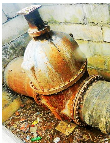
Obr. 3.44. Sekční kovovětšníci litinové šoupátko DN 1 200 s nestoupajícím vřetenem v armaturní šachtě č. 10 na druhém řadu přivaděče Obr. 3.45. Sekční kovovětšníci litinové šoupátko DN 1 200 s nestoupajícím vřetenem v armaturní šachtě č. 16 na prvním řadu přivaděče Obr. 3.46. Sekční kovovětšníci litinové šoupátko DN 1 200 s nestoupajícím vřetenem v armaturní šachtě č. 34 na prvním řadu přivaděče
