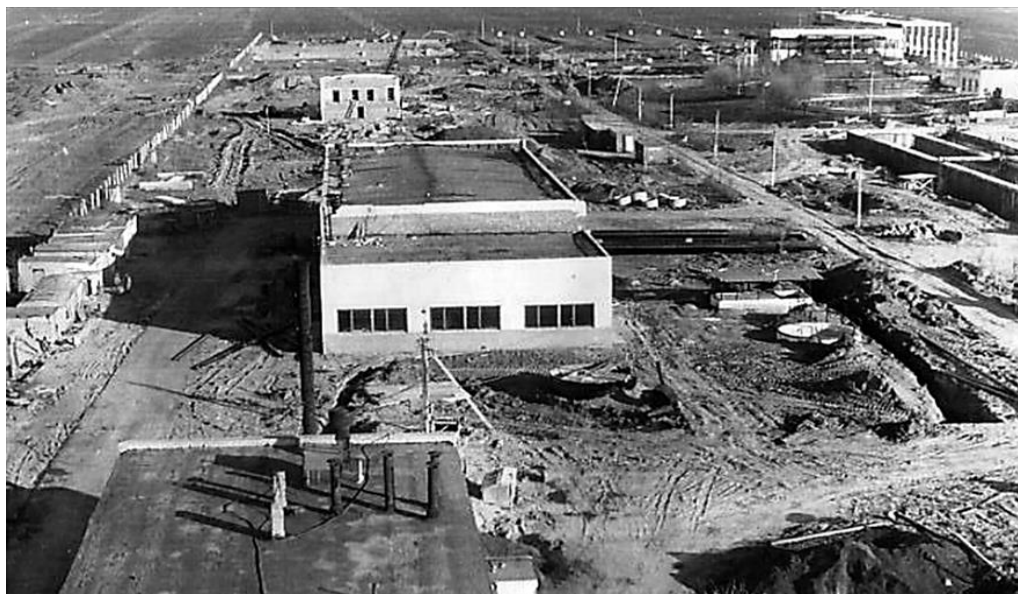
Obr. 2.3. Výstavba prvního bloku úpravnou vody Ingulec [1]
