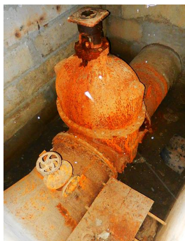
Obr. 3.44. Sekční kovovětšníci litinové šoupátko DN 1 200 s nestoupajícím vřetenem v armaturní šachtě č. 10 na druhém řadu přivaděče Obr. 3.45. Sekční kovovětšníci litinové šoupátko DN 1 200 s nestoupajícím vřetenem v armaturní šachtě č. 16 na prvním řadu přivaděče Obr. 3.46. Sekční kovovětšníci litinové šoupátko DN 1 200 s nestoupajícím vřetenem v armaturní šachtě č. 34 na prvním řadu přivaděče
