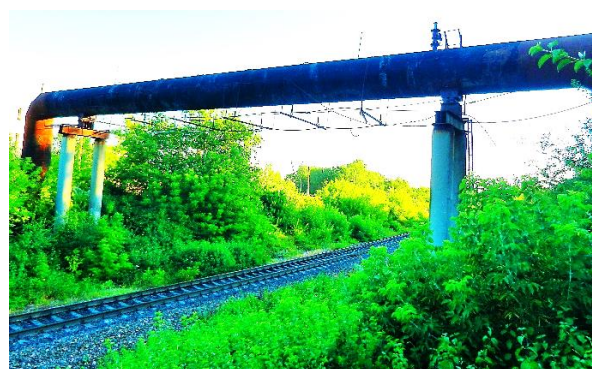
Obr. 3.43. Přemostění prvního řadu přivaděče přes železnici u úpravny vody Ingulec
