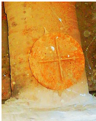
Obr. 3.68. Vstupní otvor v armaturní šachtě č. 15 na druhém řadu přivaděče
