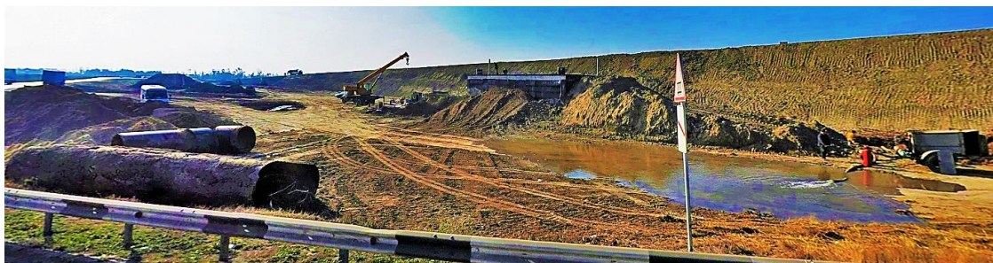
Obr. 3.134. Výstavba přepínací komory a výměna úseků přivaděče v průběhu rekonstrukce dálnice E-58, M-14 [2]
