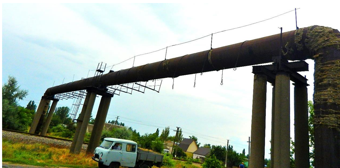
Obr. 3.28 a 3.29. Přemostění prvního řadu přivaděče přes železnici Cherson-Mykolajiv, silnici E-58, M-14, P-47 a přes žlab dešťové kanalizace u předměstí města Cherson
