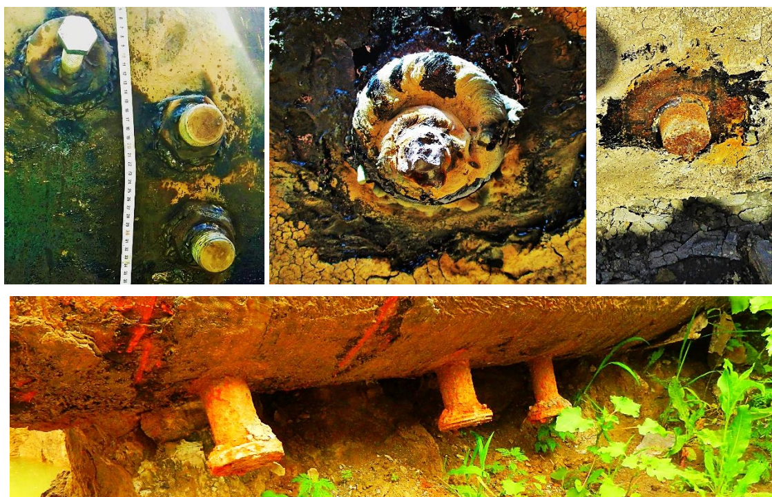
Obr. 3.120, 3.121, 3.122 a 3.123. Opravy úseku 1. řadu přivaděče Dnipro-Mykolajiv v okolí vesnice Myrné pomocí přivařování zásepek a šroubů k tělesu potrubí
