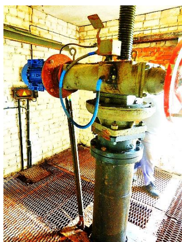
Obr. 3.47, 3.48 a 3.49. Sekční kovovětšníci ocelové šoupátko DN 1 000 se stoupajícím vřetenem s elektrickým servomotorem v armaturní šachtě č. 13 na prvním řadu přivaděče u zvyšovací stanice Cherson
