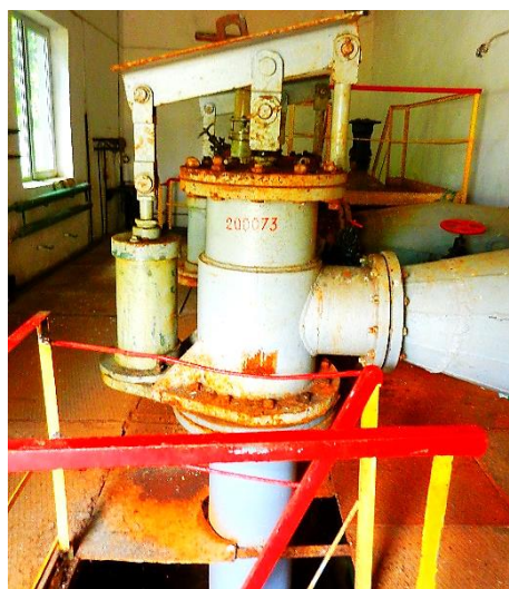
Obr. 3.24 a 3.25. Automatické tlumiče tlakových rázů typu ГY-350 na druhém řadu přivaděče
