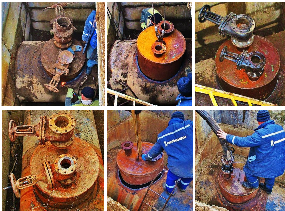
Obr. 3.135, 3.136, 3.137, 3.138, 3.139 a 3.140. Výměna sběračů vzduchu a šoupátek ve vzdušnickových šachtách [2]
