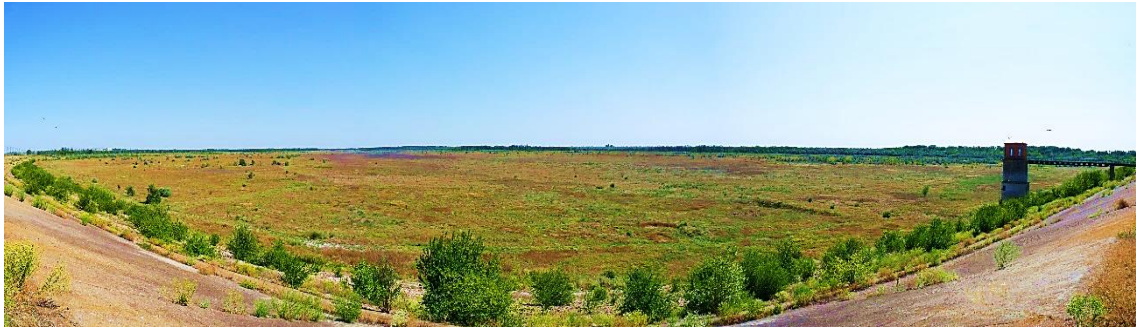
Obr. 2.4. Kompletně vypuštěná vodní nádrž Žovtnevá
