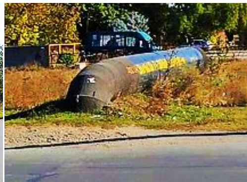
Obr. 3.27. Technologický nadchod druhého řadu nad prvním řadem u města Cherson
