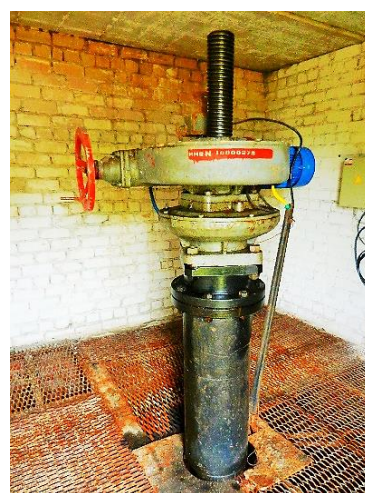
Obr. 3.47, 3.48 a 3.49. Sekční kovovětšníci ocelové šoupátko DN 1 000 se stoupajícím vřetenem s elektrickým servomotorem v armaturní šachtě č. 13 na prvním řadu přivaděče u zvyšovací stanice Cherson
