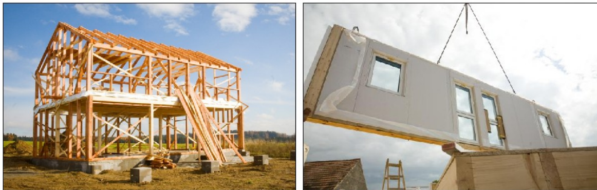
Obr. 1: Rámová nosná konstrukce (vlevo) (zdroj: www.woodsystm.cz )
