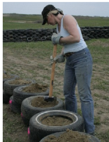
Obr. 11: Využití starých pneumatik pro založení dřevostavby ( www.middleearthhome.com )
