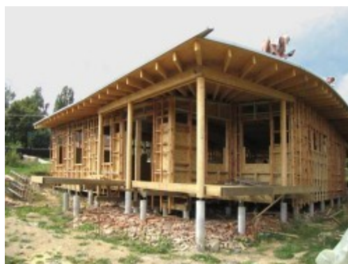
Obr. 9: Stavba založená na mikropilotech (stavba.tzb-info.cz)
