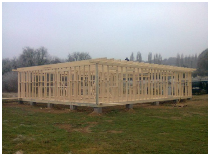
Obr. 8: Založení stavby na betonových patkách ( www.tbf-drevostavby.cz )
