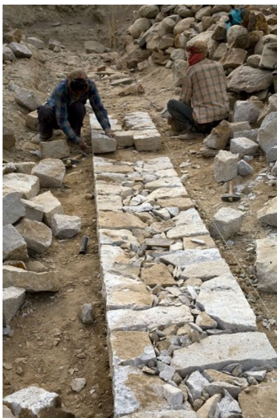
Obr. 7: Budování kamenných základů pro stavbu ( https://archistrata.signalny.cz )
