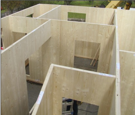
Obr. 4: Masivní dřevostavba z panelů (ww.nazeleno.cz)
