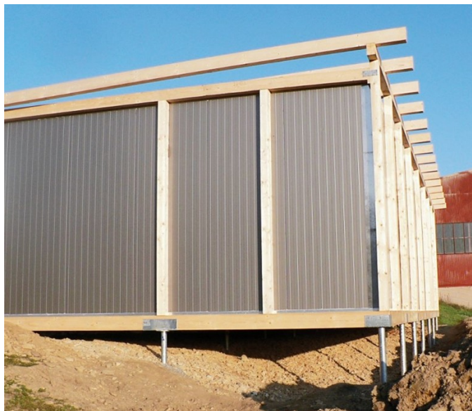
Obr. 10: Použití zemních vrutů pro založení dřevostavby ( www.zemnivruty.cz )
