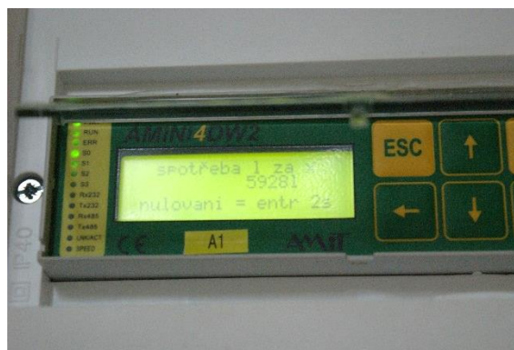
Obr. 28: Zobrazení kumulovaného průtoku systém MaR
