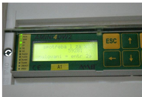
Obr. 28: Zobrazení kumulovaného průtoku systém MaR
