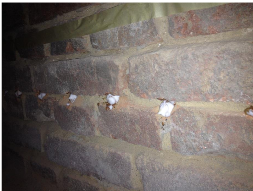
Obr. 36 – Vrtky injektované hydroizolačním gelem
