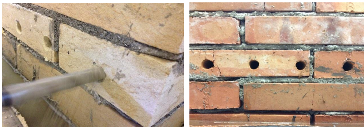
Obr. 27 – Příprava injektážních vrtů (postupně: cihla pískovcová, cihla plná pálená)
