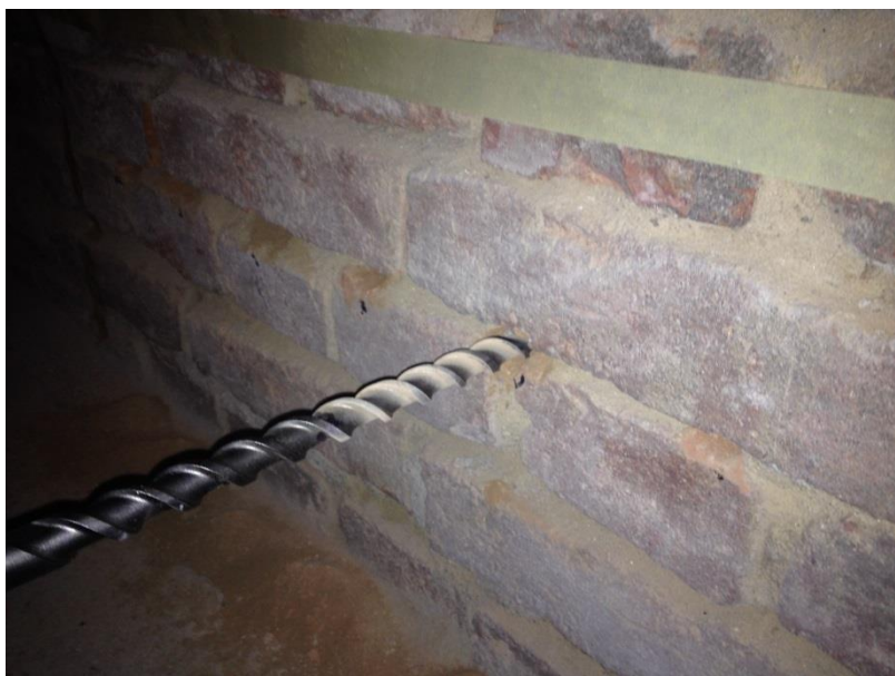
Obr. 35 – Příprava injektážních vrtů v reálné stavební struktuře
