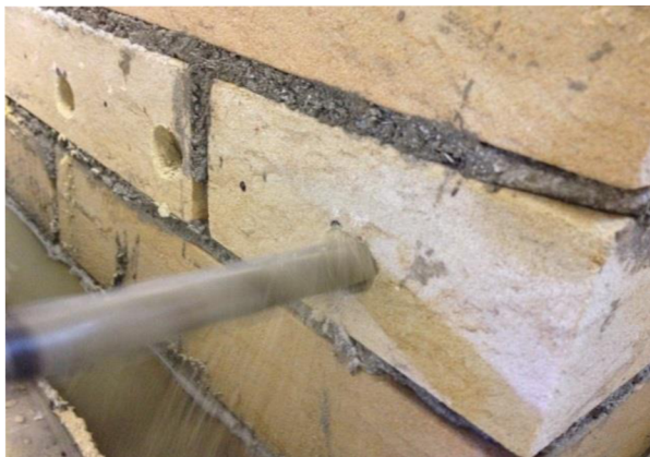
Obr. 27 – Příprava injektážních vrtů (postupně: cihla pískovcová, cihla plná pálená)
