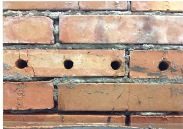
Obr. 27 – Příprava injektážních vrtů (postupně: cihla pískovcová, cihla plná pálená)
