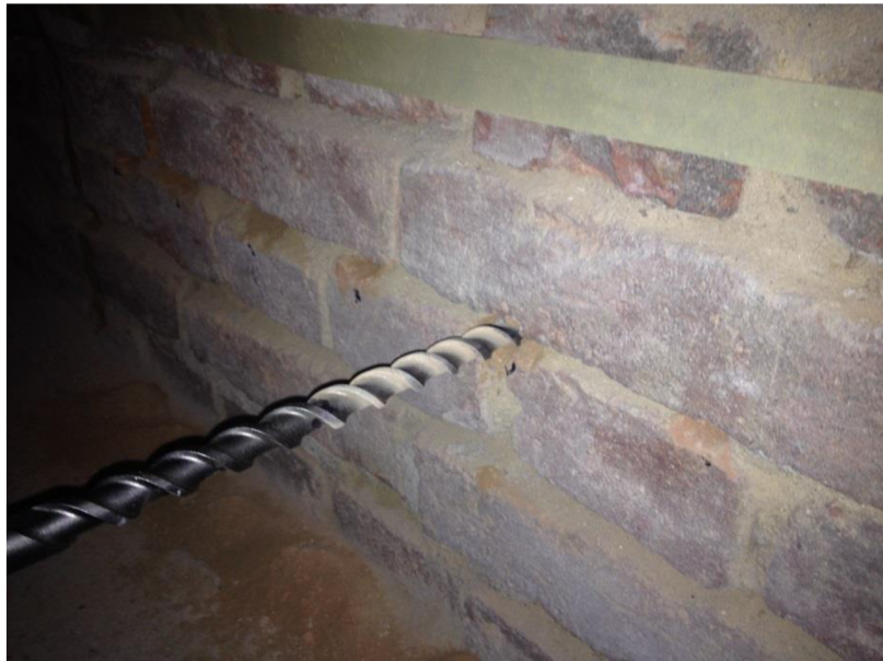
Obr. 35 – Příprava injektážních vrtů v reálné stavební struktuře
