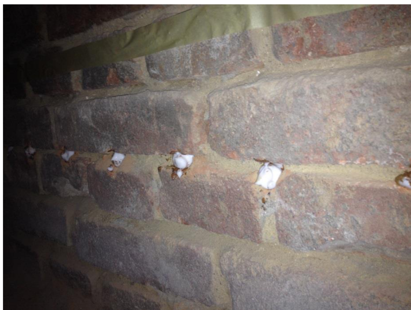
Obr. 36 – Vrtky injektované hydroizolačním gelem
