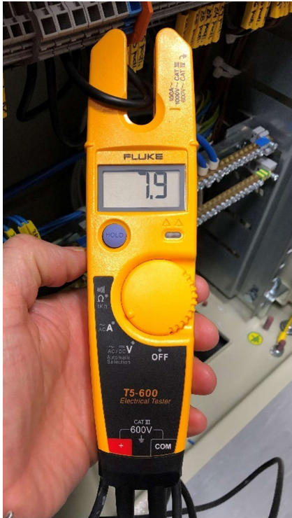
Obr. 9.21: Kontrola napájení DDC
