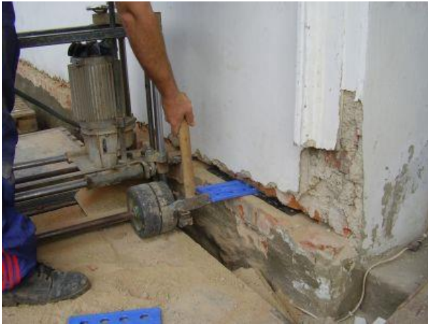
Obrázek 8: Ukázka podřezávání řetězovou pilou a vrážení klínu [10]
