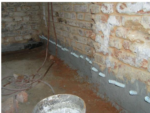
Obrázek 17: Ukázka beztlakové injektáže [15]
