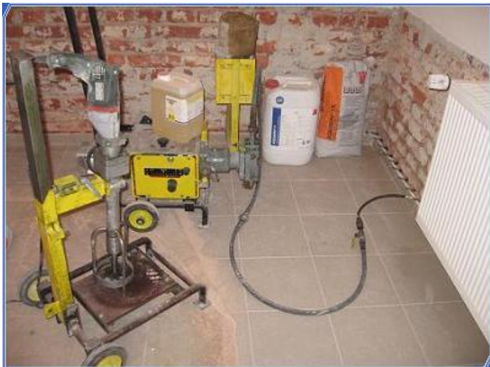
Obrázek 20: Ukázka tlakové injektáže [18]
