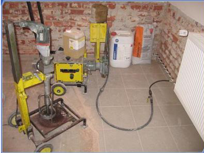
Obrázek 20: Ukázka tlakové injektáže [18]
