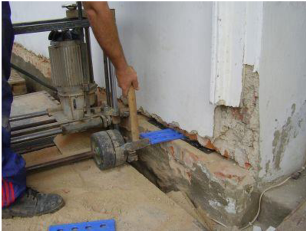
Obrázek 8: Ukázka podřezávání řetězovou pilou a vrážení klínu [10]
