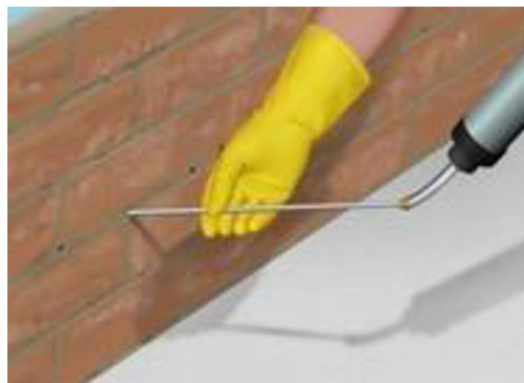
Obrázek 12: Ukázka možné aplikace hydroizolační clony[13]
