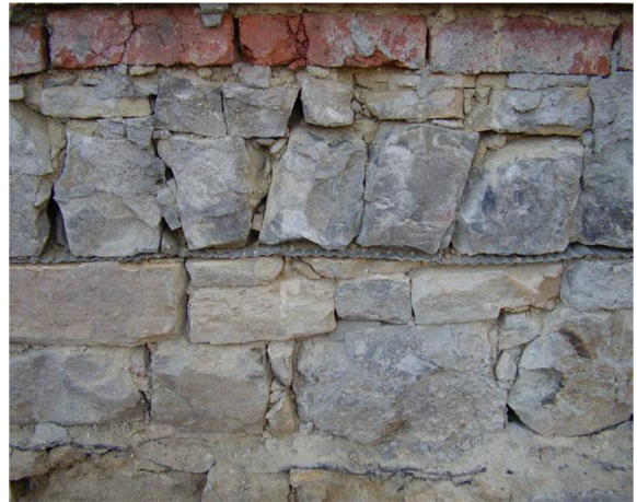
Obrázek 9: Nerezový plech ve smíšeném zdivu [10]
