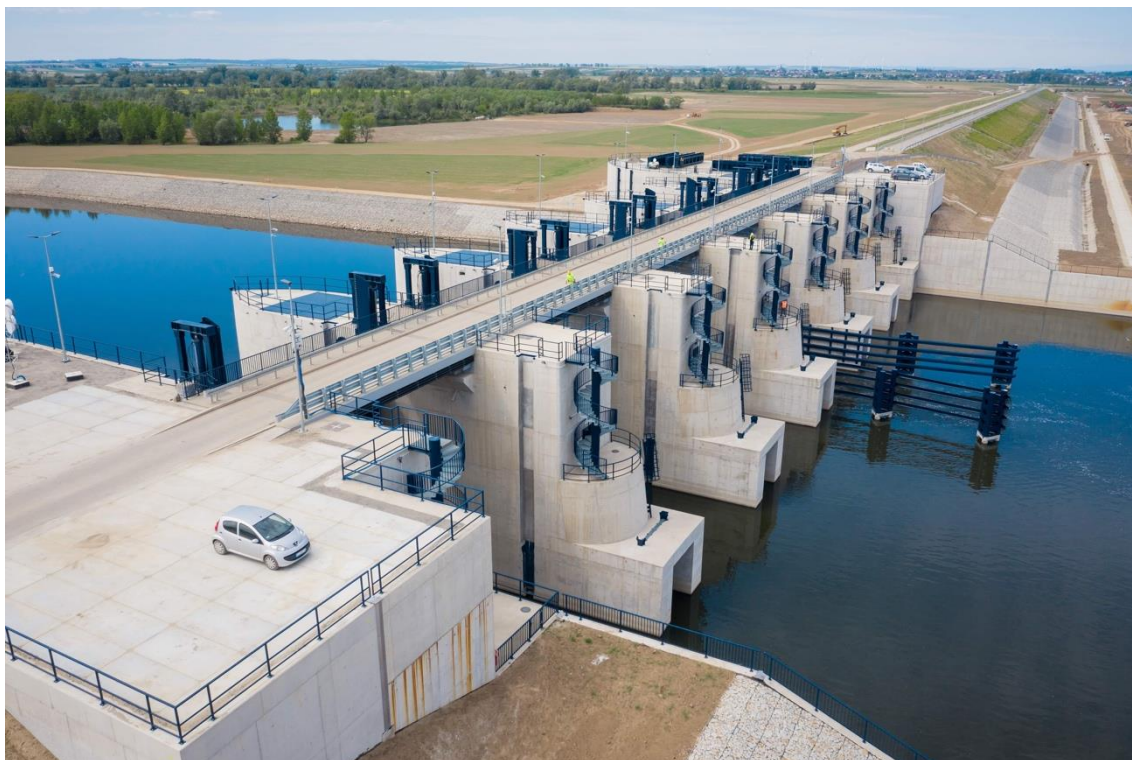
Obrázek 3: Výpustní objekt poldru v Ratiboři, severní pohled (Zdroj: Wody Polskie, 2020)
