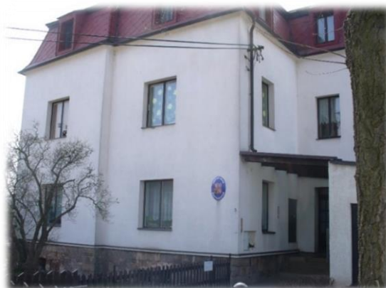
Obrázek č. 4 – Obecní úřad a mateřská škola v Martínkovicích
