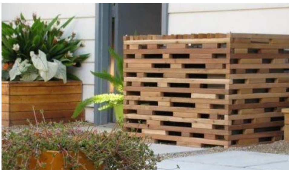
Obr. 2-14 Zakrytí venkovní jednotky z profilů [33]
