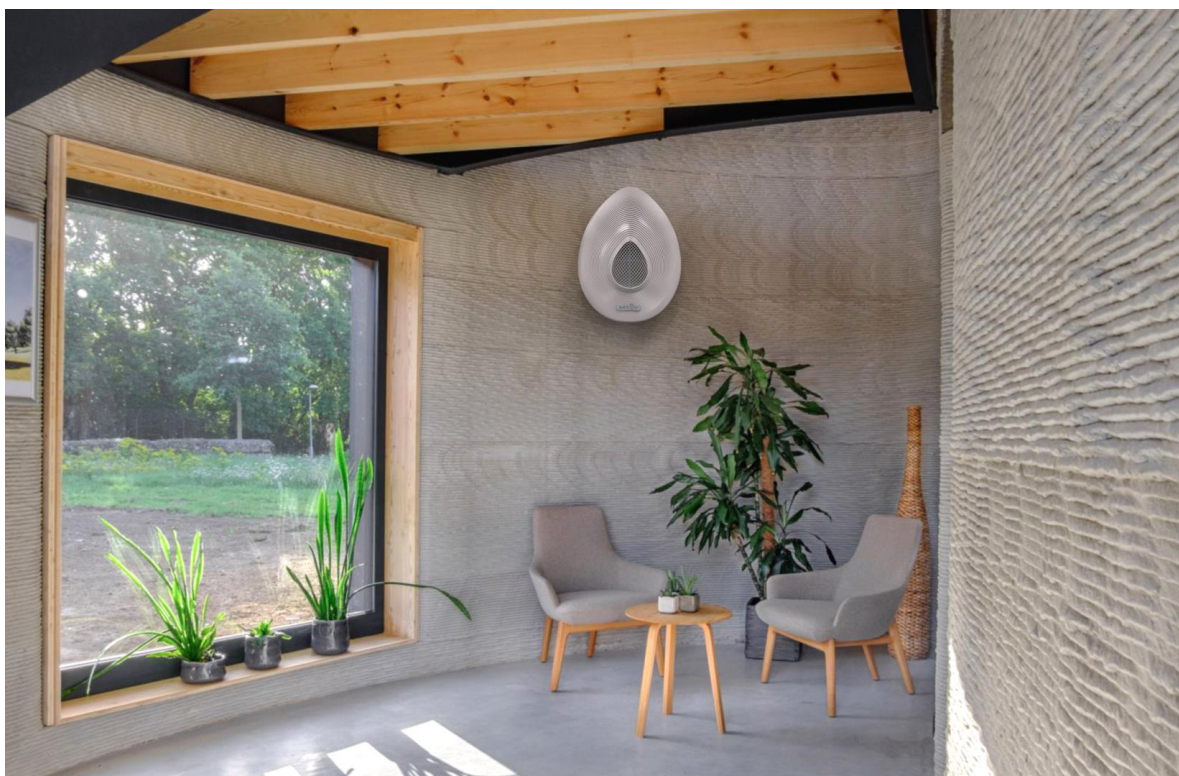
Obr. 8-4 Vnitřní jednotka v interiéru 3D tištěného domu
