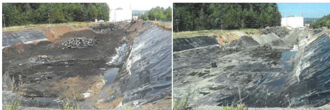
Obr. č. 17 a 18 Průběh sanace.
