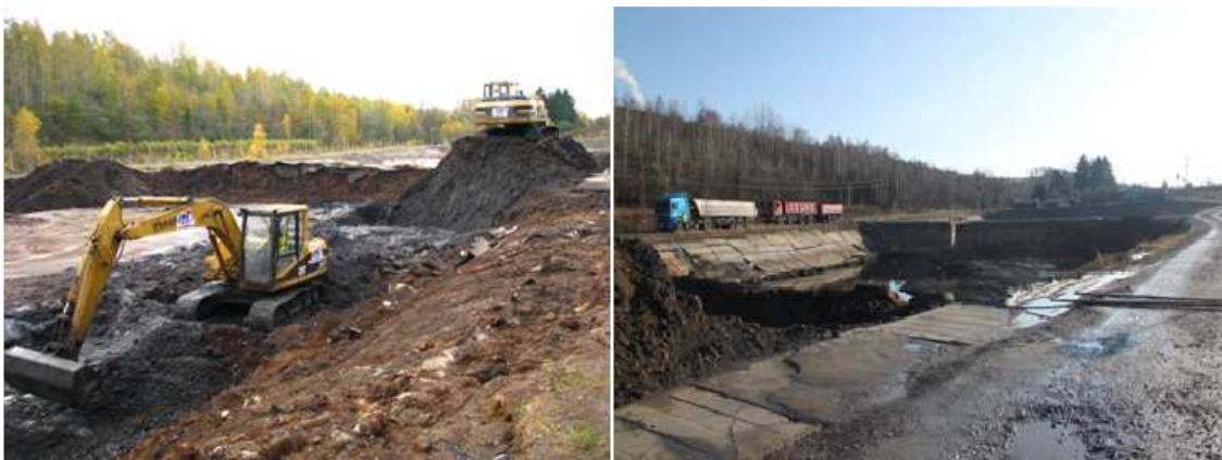
Obr. č. 6 a 7 Odtěžba skládky v roce 2009 (archiv Kovohutě Příbram nástupnická, a.s.).
