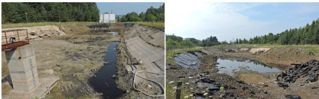
Obr. č. 10 a 11 Skládka SS před zahájením odtěžovacích prací
