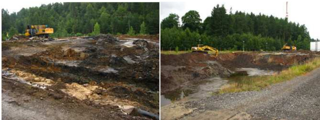
Obr. č. 4 a 5 Zahájení sanace - odkryv rekultivované části v roce 2009 (archiv Kovohutě Příbram nástupnická, a.s.).
