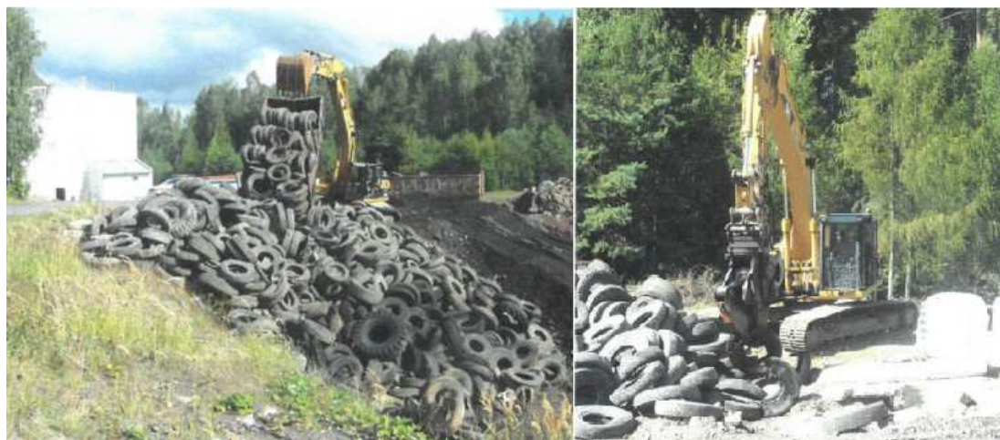
Obr. č. 19 Shromažďování vytěžených pneumatik; obr. č. 20 Stříhání pneumatik.
