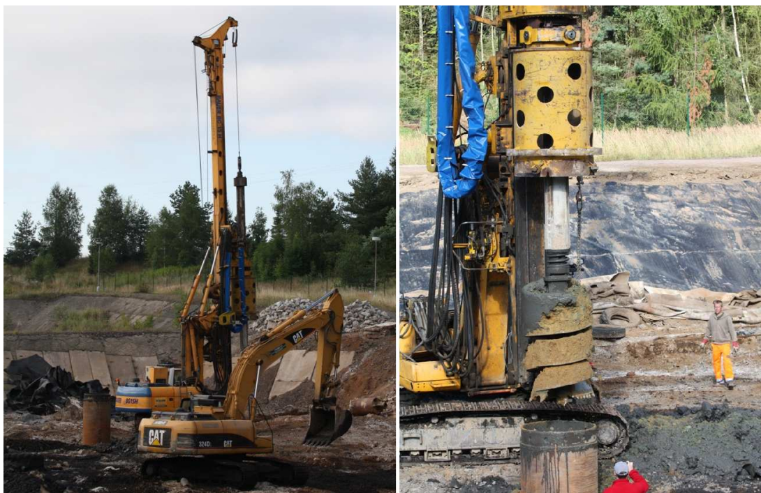
Obr. č. 12 a 13 Vrtání čerpacích objektů proti vnikání spodních vod do skládky.
