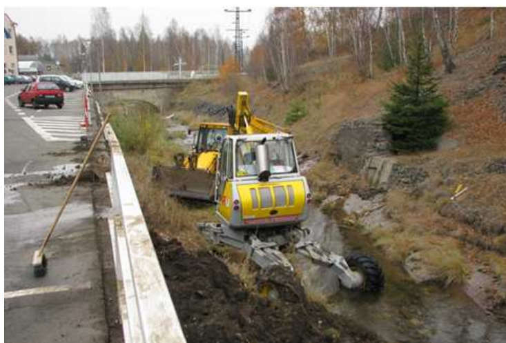
Obr. č. 9 Výstavba limnigrafické stanice (archiv Kovohutě Příbram nástupnická, a.s.).
