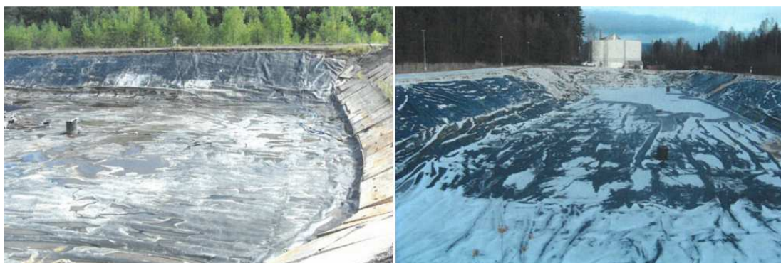
Obr. č. 23 Odtěžený a vyčištěný prostor laguny; obr. č. 24 Ukončení sanace.
