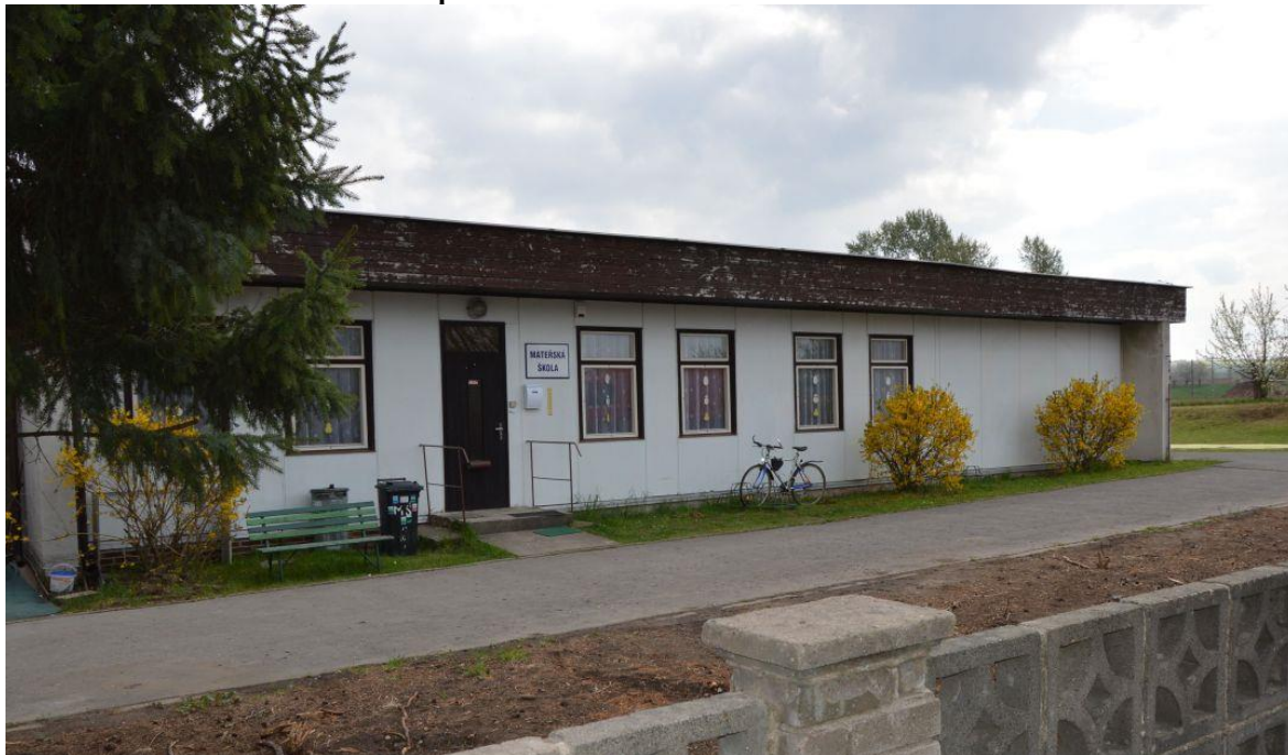
Obrázek 5: Mateřská škola Velim před rekonstrukcí
