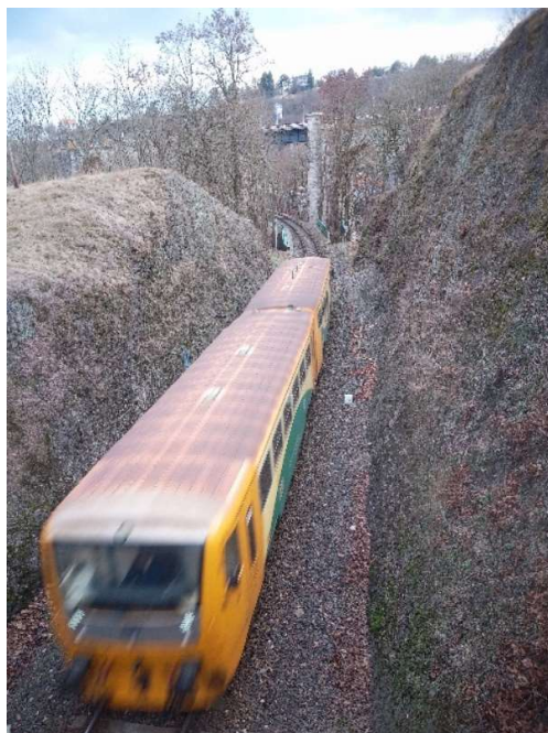
Obr. 5: PP Železniční zářez
