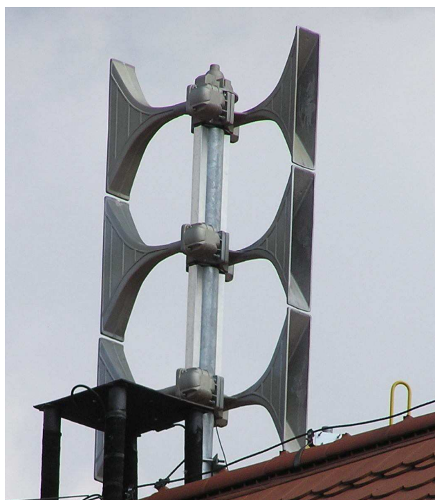
Obrázek č.4: Elektronická siréna ESP 750 W (12)
