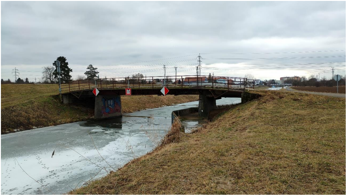
Obr. 1: Most přes Baťův kanál v Uherském Hradišti. (Autor: Kašpar Matěj, leden 2022)
