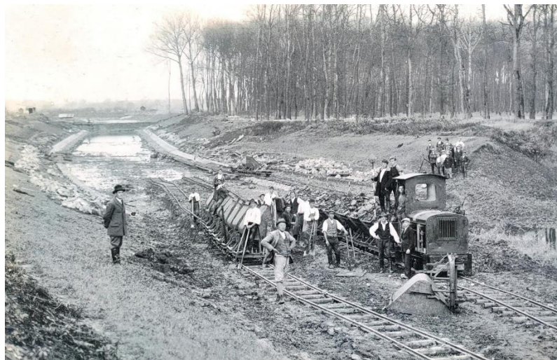
Obr. 1: Využití kolejí pro odvoz vytěženého materiálu Zdroj: Výstava Most přes Moravu v Kostelanech
