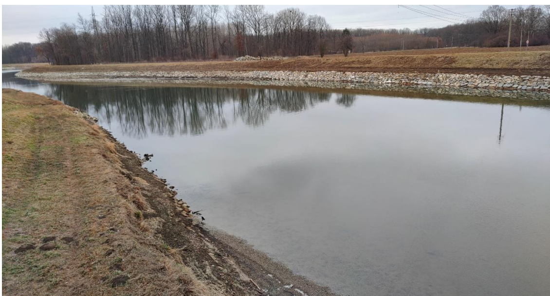
Obr. 6: Nové zpevnění břehu u Kostelan nad Moravou. (Autor: Kašpar Matěj, leden 2022)
