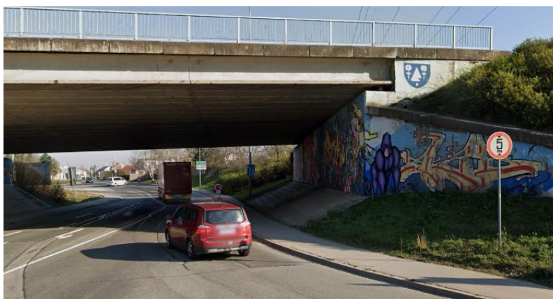
Obrázek 4: Trasa z betonárny – Kritický bod 2 [2]
