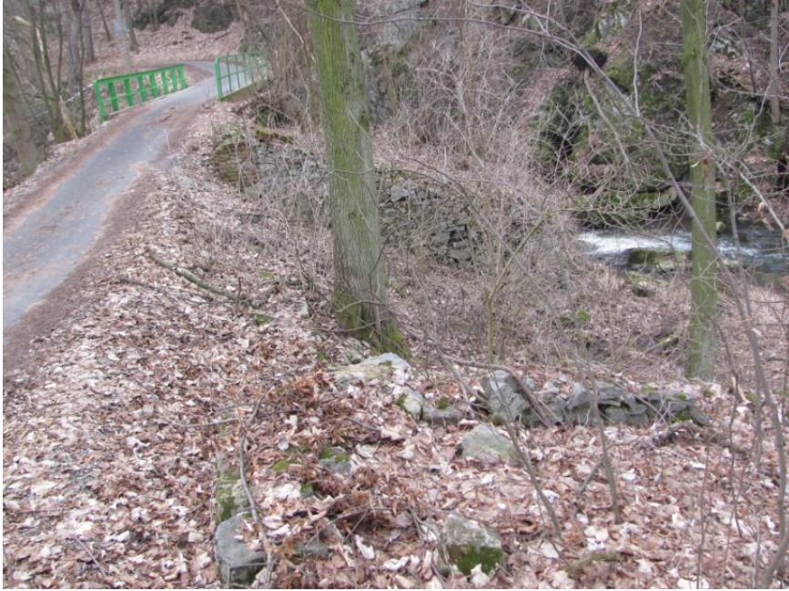
Příl. 11: Rybník u Horního Újezdu, zbytky výpusti.
