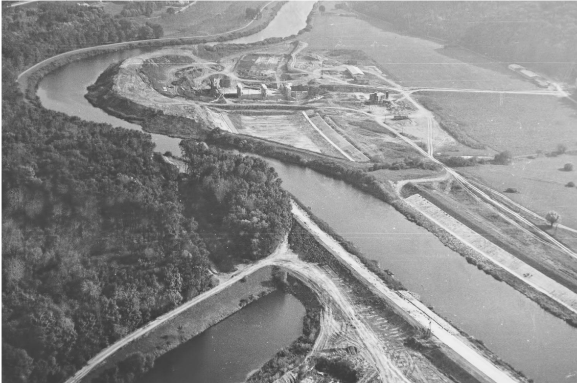
Obr. 2: Historický letecký snímek stavby jezu na řece Moravě z října 1964
