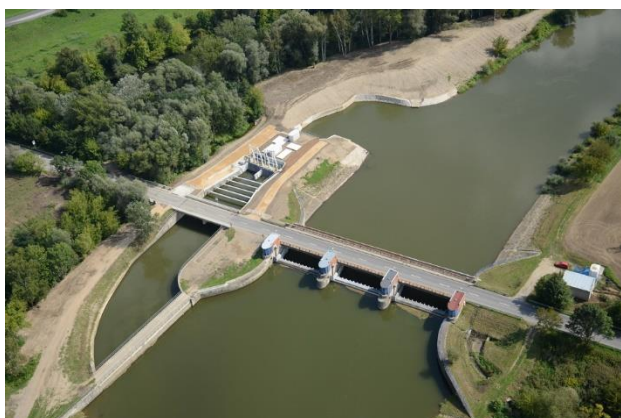
Obr. 8: Jez s malou vodní elektrárnou
