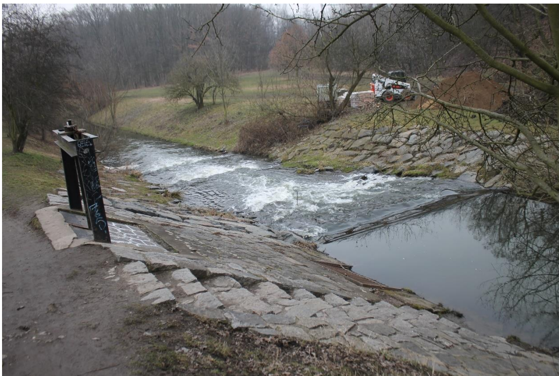
Příloha 4: Balvanitý skluz u stavidla a schody podél Hořejšího rybníka
