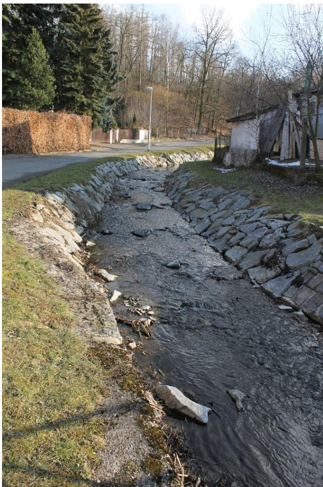
Příloha 17: Opevněné koryto Rokytky pomocí kamenné rovnániny v Nedvězí
