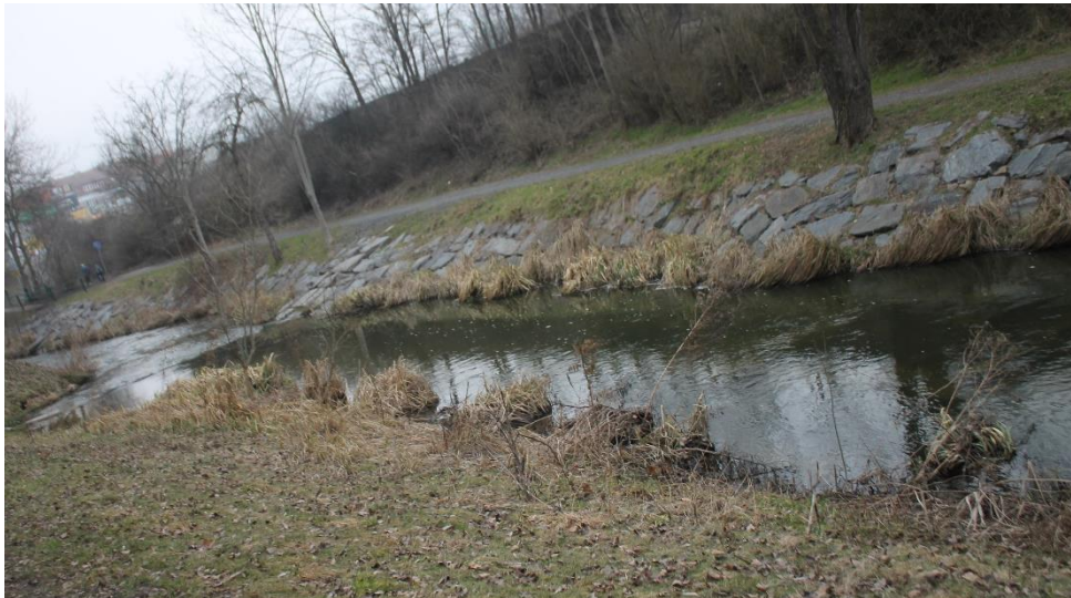
Obrázek 9: Břehy opevněny balvanitou rovnáninou nad Hořejším rybníkem
