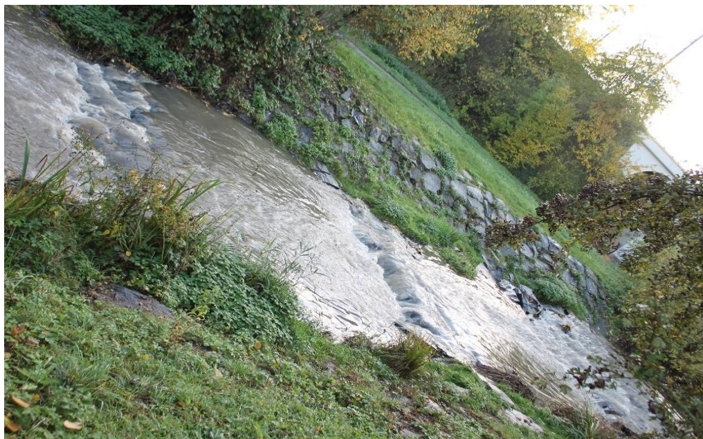
Obrázek 7: Balvanitý skluz podél Hořejšího rybníka
