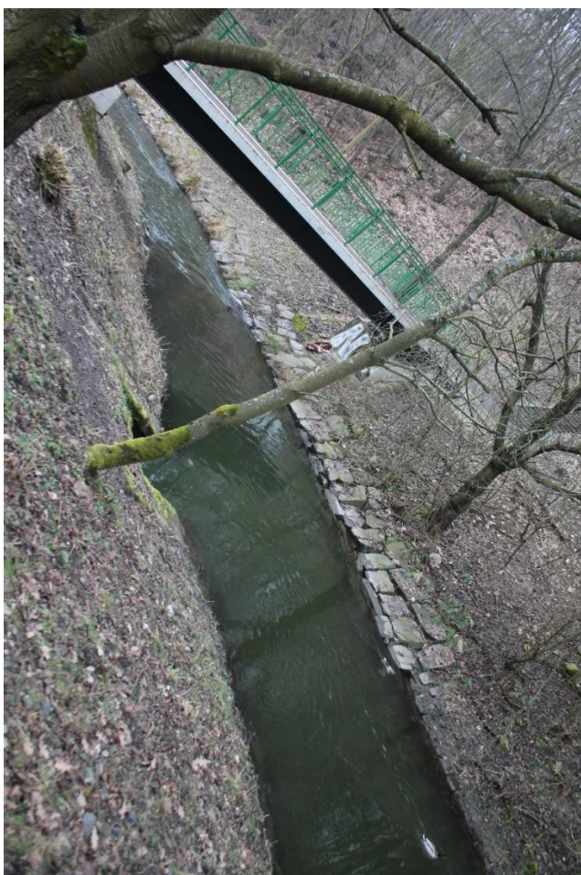
Příloha 6: Zpevněné koryto podél Hořejšího rybníka
