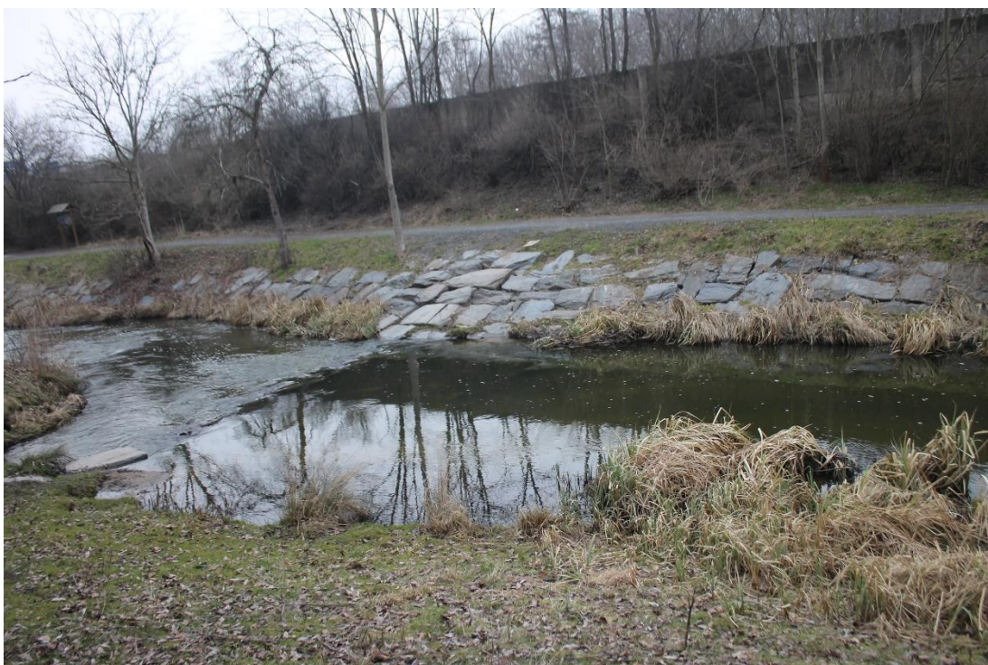
Příloha 10: Zpevnění břehů pomocí kamenité rovnániny pod Hořejším rybníkem
