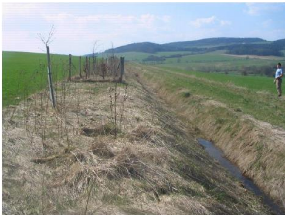
Foto 8 Protierozní mez se sběrným příkopem v k. ú. Němčice (Kadlec a kol., 2015).
