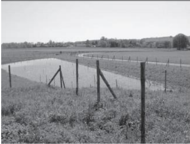
Foto 11 Výstavba zpevněné polní cesty C5 v k. ú. Skřípov, okres Prostějov (Koudelka, 2009).
