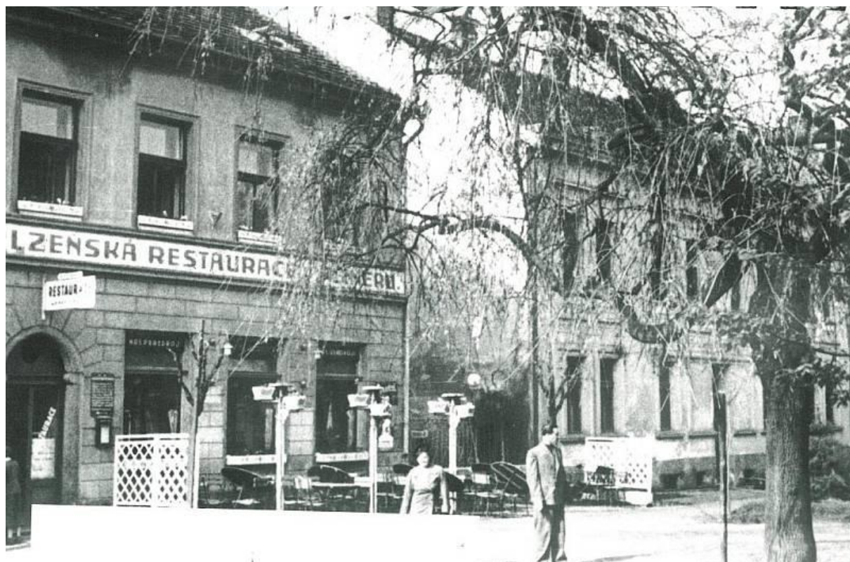
Obr. 4 Dům U Reinerů v Palackého sadech v Písku, 30.-40. léta 19. století, dobová fotografie průčelí domu
