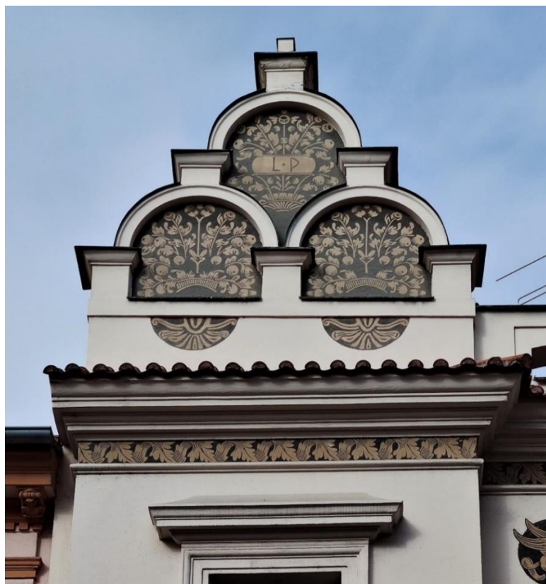
Obr. 15 Jan Koula, dům Adolfa Heyduka v Tyršově ulici v Písku, 1900, pohled na menší štít, současný stav
