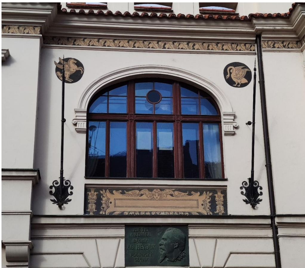
Obr. 11 Jan Koula, dům Adolfa Heyduka v Tyršově ulici v Písku, 1900, pohled na šestidílné obloukově klenuté okno ve střední ose 1. patra, současný stav
