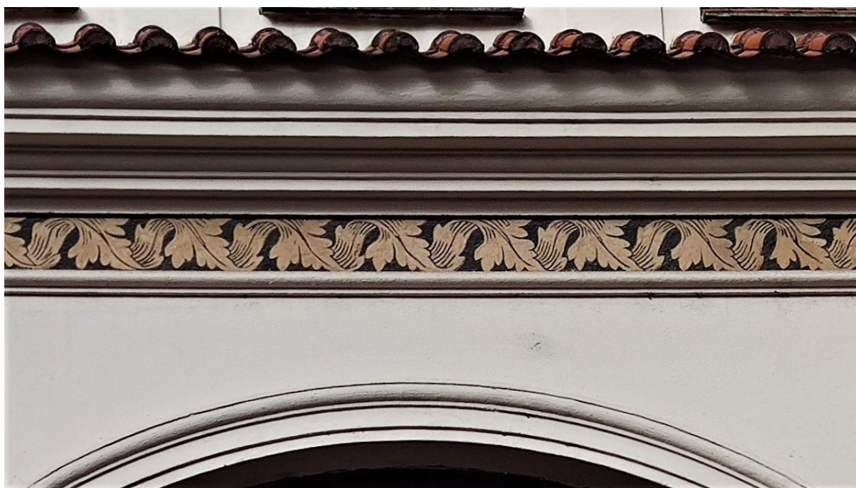
Obr. 14 Jan Koula, dům Adolfa Heyduka v Tyršově ulici v Písku, 1900, detailní pohled na sgrafitový pruh s akantovými listy pod římsou, současný stav
