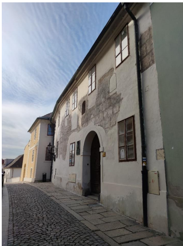
Obr. 3 Dům U Koulí v ulici Fráni Šrámka v Písku, původně renesanční z poloviny 16. století, klasicistně přestavěn v letech 1810 a 1821, celkový pohled na fasádu
