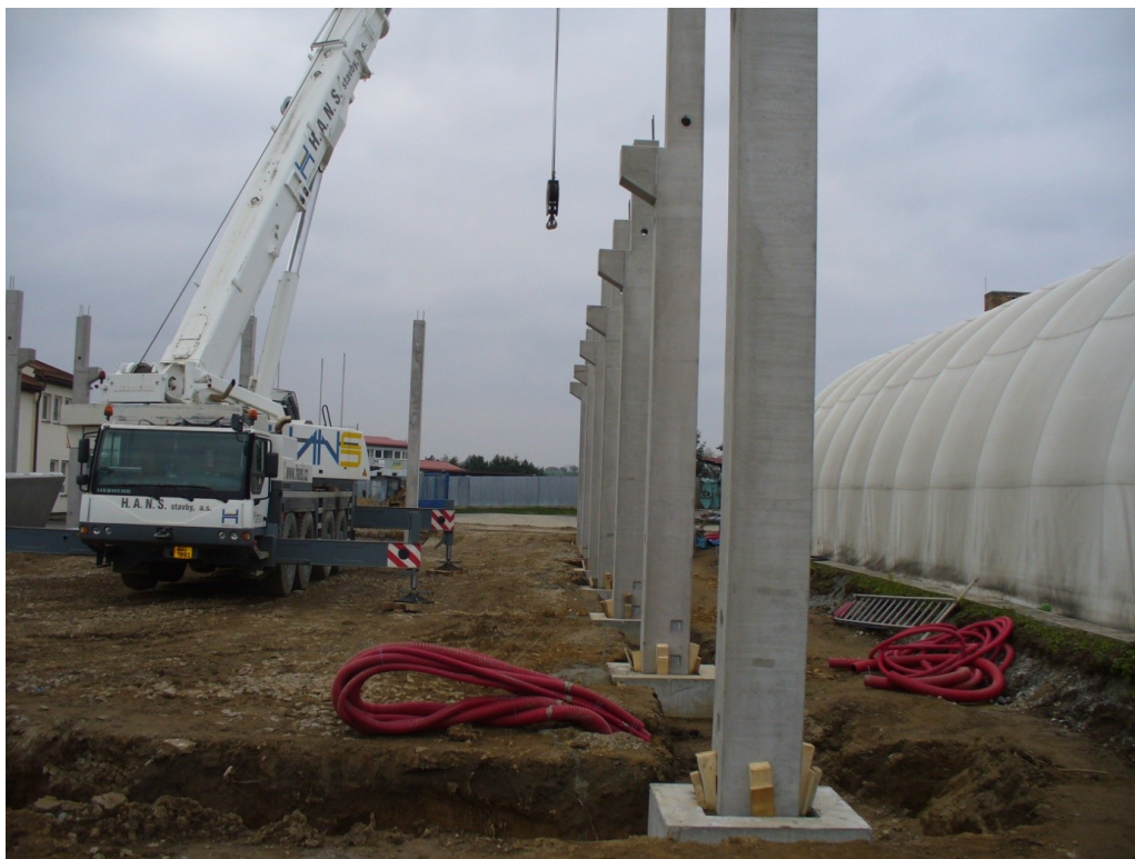
Obr. 4. 1 - Praktické znázornění osazení a vyklínování sloupů na dané stavbě
