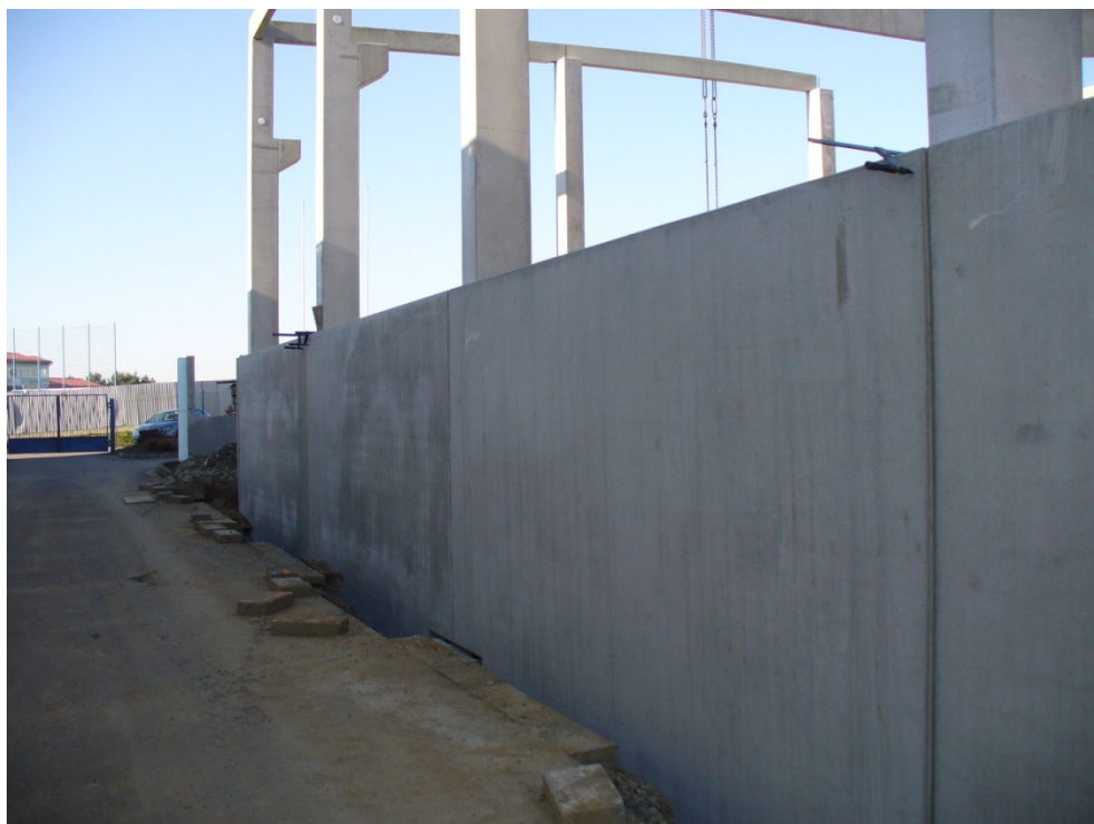
Obr. 4. 3 - Pohled na základové/soklové prahy zvenčí
