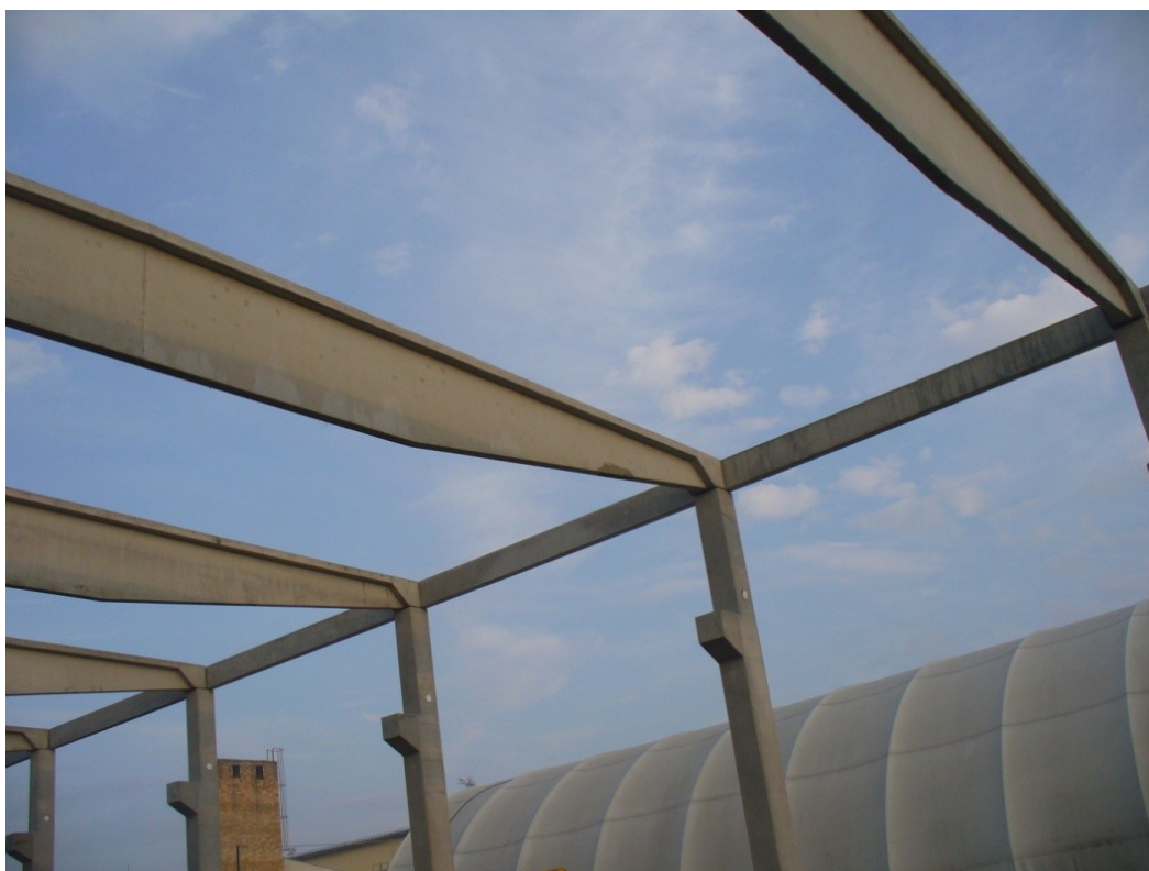
Obr. 4. 5 - Osazení vazníků a stůžidel
