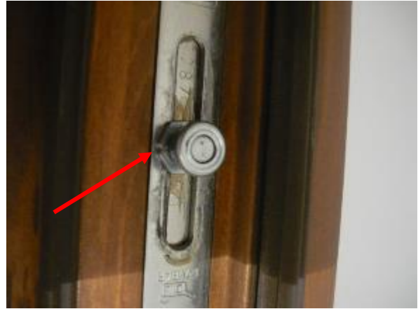
Obr. 6: Nastavení polohy kování na přítlak 0%
