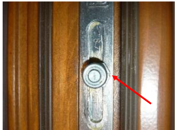
Obr. 8: Nastavení polohy kování na přítlak 100%
