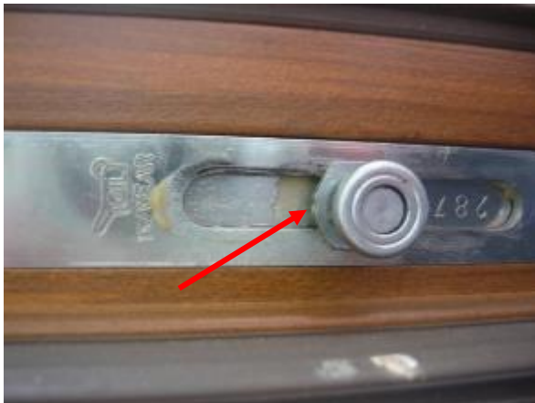
Obr. 7: Neutrální nastavení polohy kování na přítlak 50%
