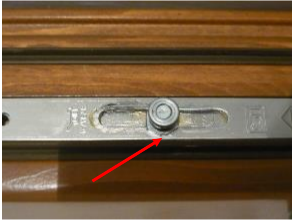
Obr. 6: Nastavení polohy kování na přítlak 0%
