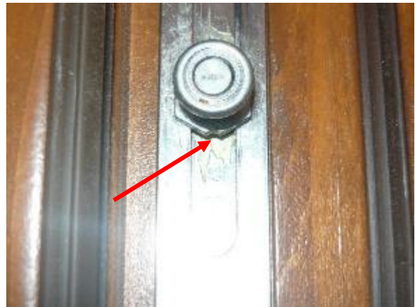
Obr. 7: Neutrální nastavení polohy kování na přítlak 50%
