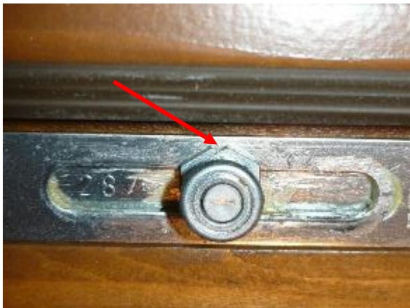
Obr. 8: Nastavení polohy kování na přítlak 100%
