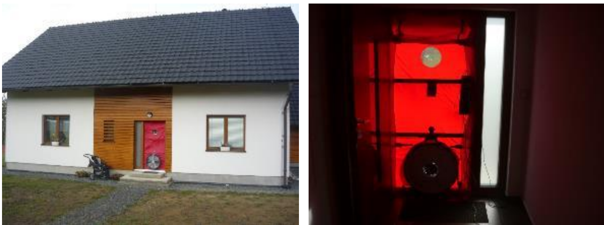
Obr. 5: Osazení měřícího zařízení (BLOWERDOOR) v měřené stavbě
