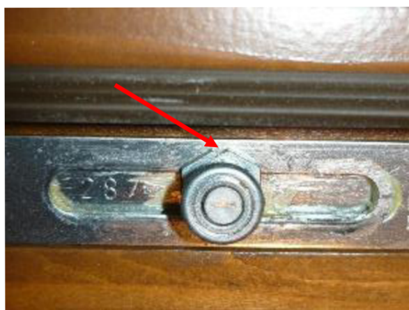
Obr. 8: Nastavení polohy kování na přítlak 100%
