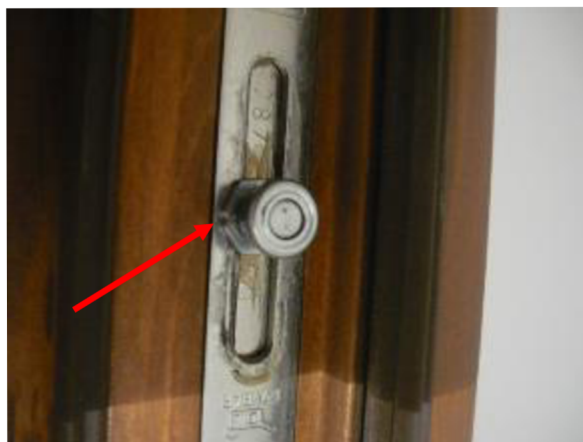
Obr. 6: Nastavení polohy kování na přítlak 0%
