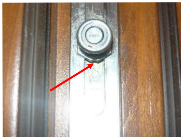
Obr. 7: Neutrální nastavení polohy kování na přítlak 50%
