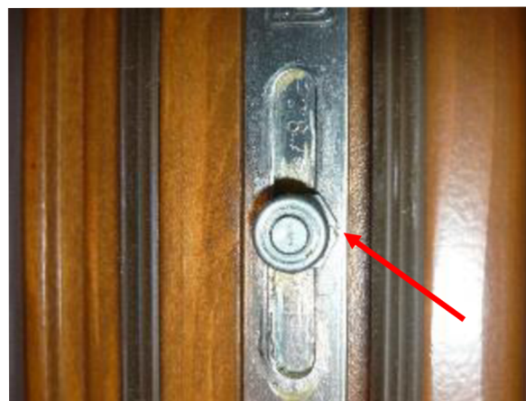
Obr. 8: Nastavení polohy kování na přítlak 100%
