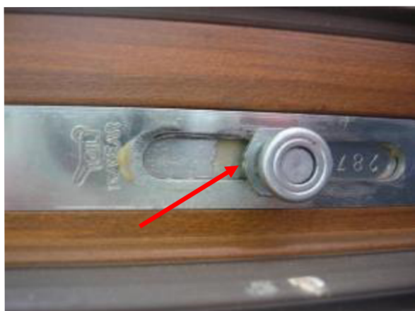
Obr. 7: Neutrální nastavení polohy kování na přítlak 50%
