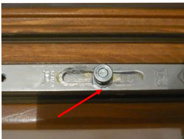
Obr. 6: Nastavení polohy kování na přítlak 0%
