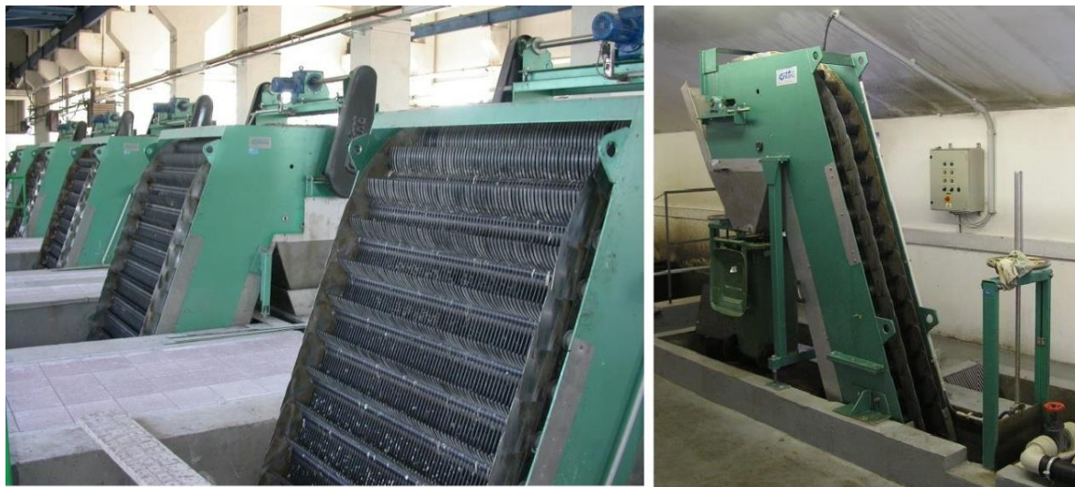
Obr. 7 Samočisticí česle [12]
