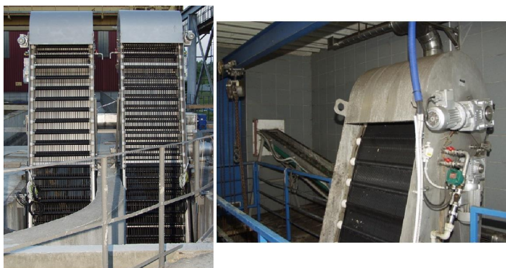
Obr. 8 Pásové česle [15]
