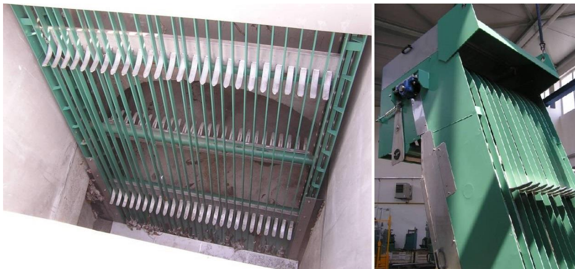
Obr. 5 Strojní česle spodem stírané [12]
