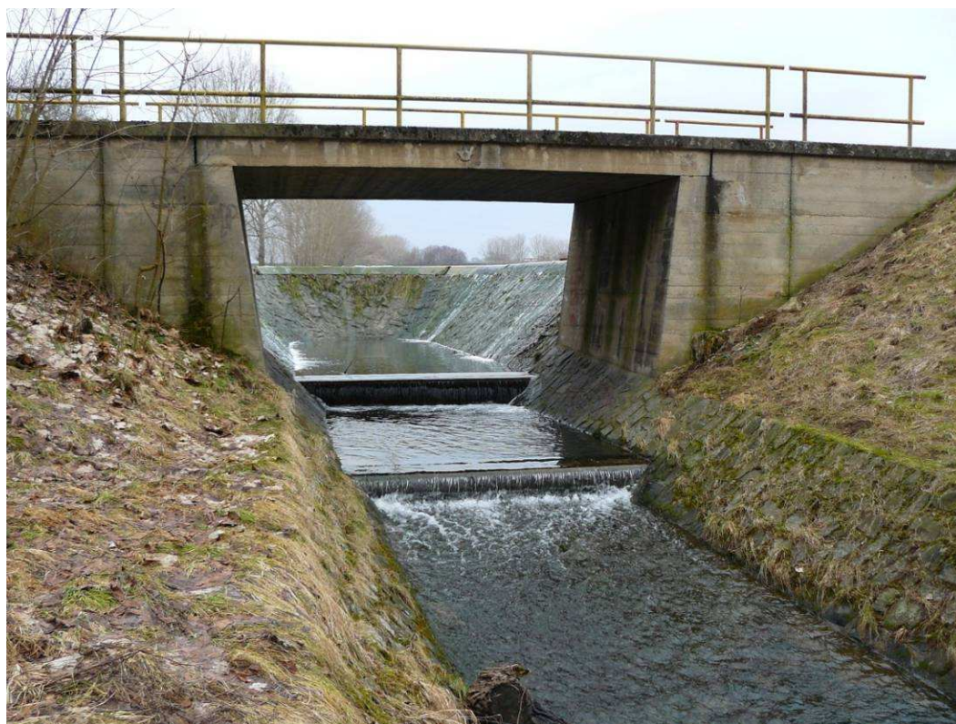
Obrázek 4: Odpad od bezpečnostního přelivu (Kebrlová 2011)
