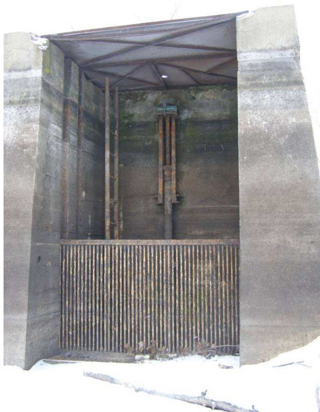
Obrázek 5: Pohled na šachtu vypouštěcího zařízení (Kebrlová, 2009)
