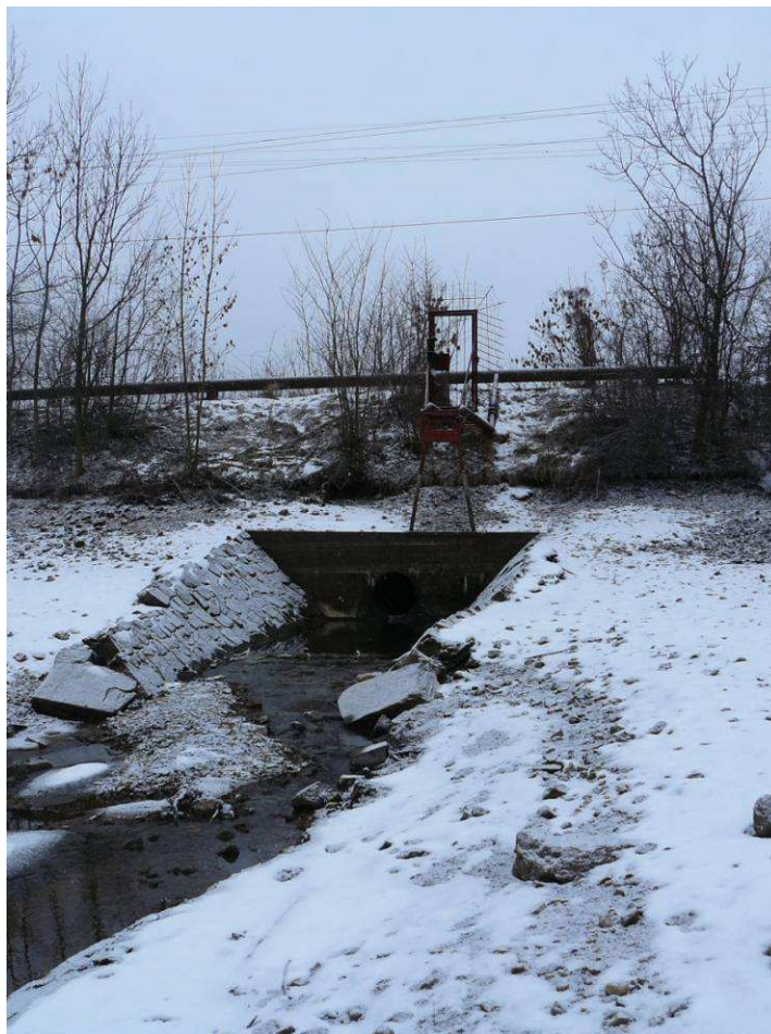
Obrázek 8: Odpad od požeráku a zároveň přítok do rybníka Blahotický Dolní. Nad odpadním potrubím je umístěno sací potrubí pro závlahy (Kebrlová 2011)
