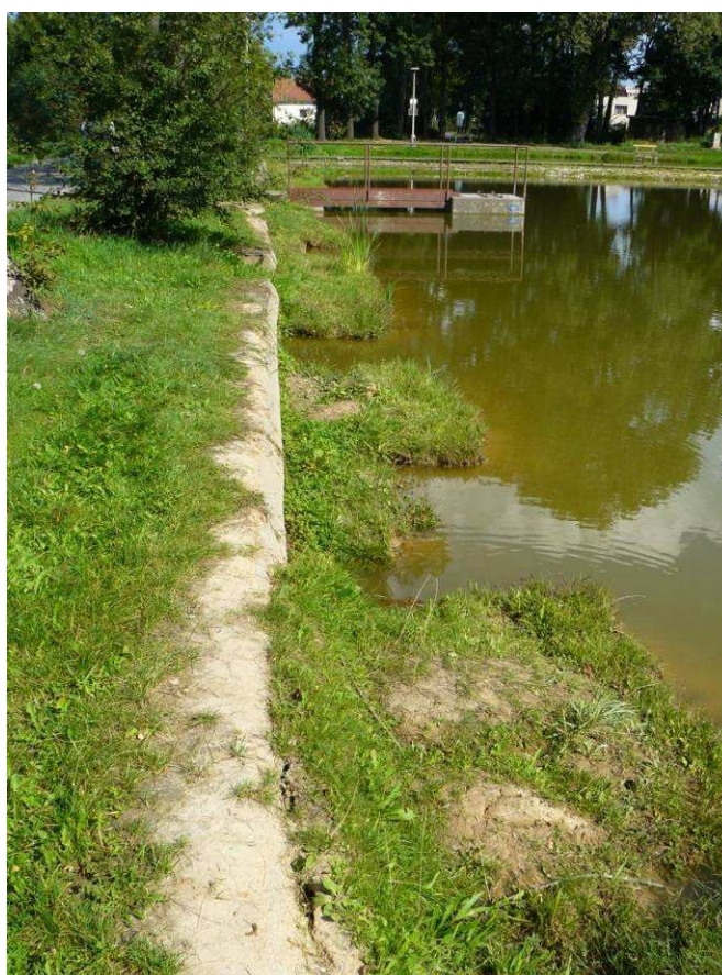
Obrázek 5: Obnažená původní betonová stěna nádrže (Kebrlová, 2010)
