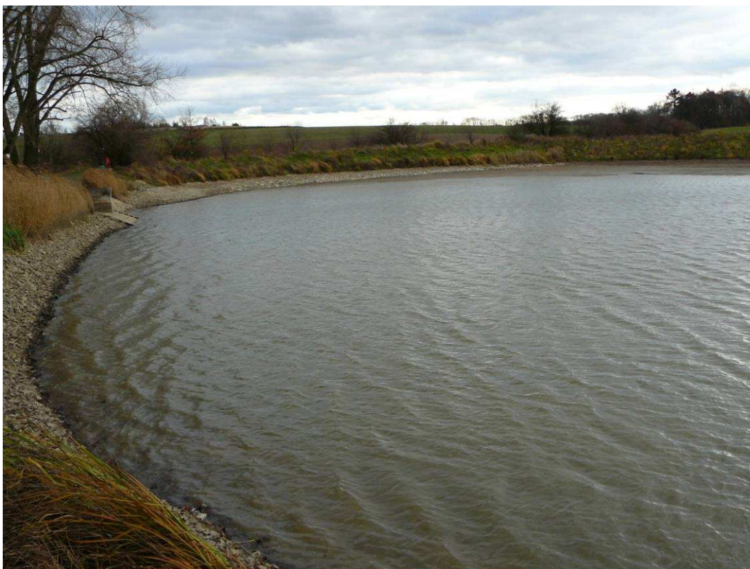
Obrázek 3: Pohled na čelní hráz z boční hráze (Kebrlová, 2010)
