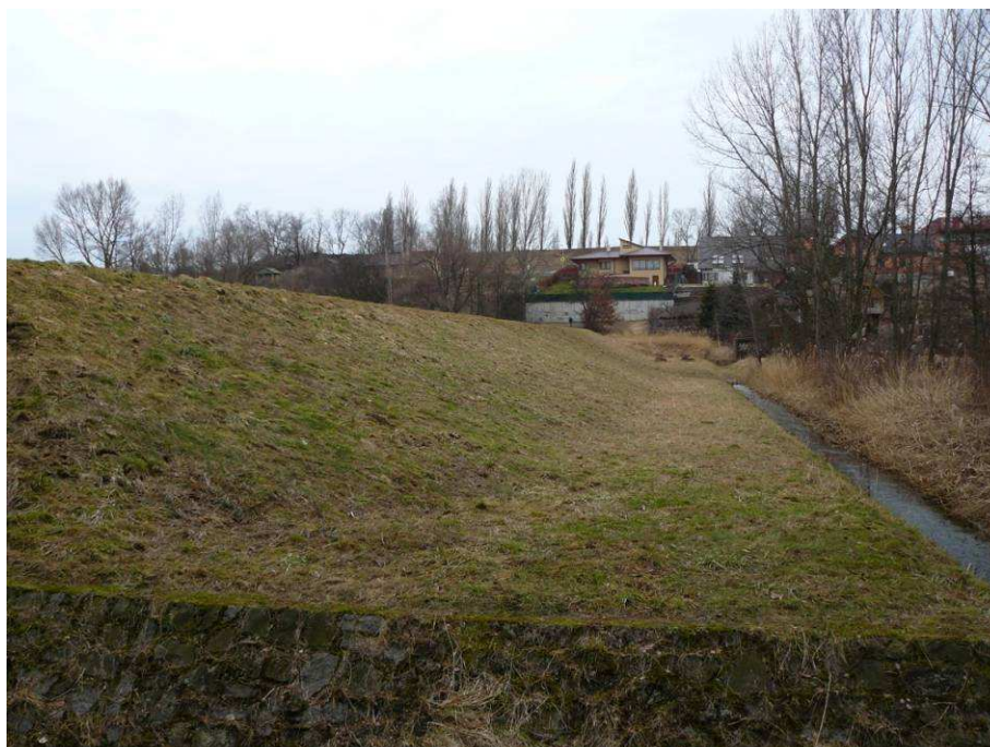
Obrázek 10: Pohled na vzdušný líc hráze od odpadu bezpečnostního přelivu (Kebrlová 2011)
