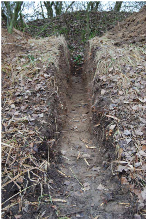
Obrázek 6: Otvor v zadní části boční hráze (Kebrlová, 2010)
