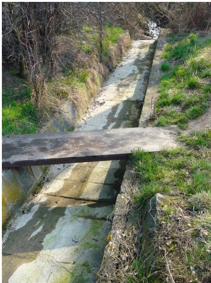
Obrázek 4: Odpad od bezpečnostního přelivu (Kebřlová, 2010)
