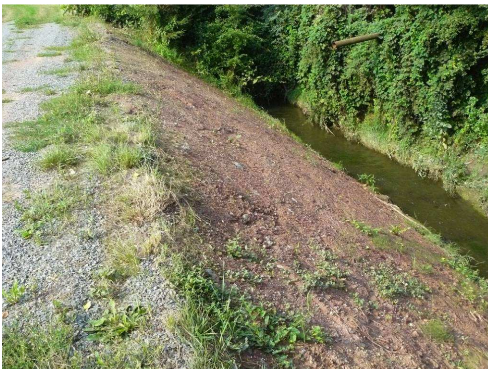
Obrázek 3: Opravená část boční hráze (Kebrlová 2010)
