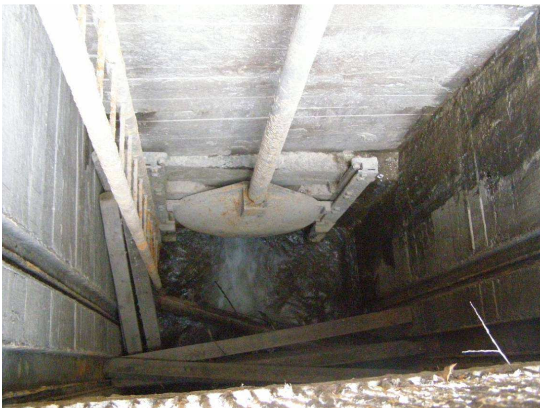
Obrázek 6: Pohled do šachty šoupátkového vypouštěcího zařízení (Kebrlová, 2009)
