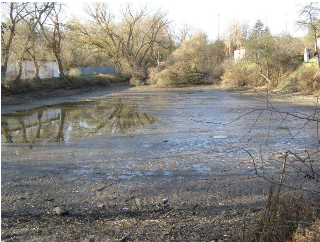
Obrázek 1: Pohled na nádrž před odbahněním z čelní hráze (Kebrlová, 2010)
