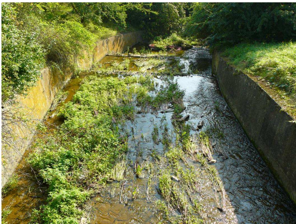
Obrázek 10: Kaskádový odpad od bezpečnostního přelivu (Kebřlová, 2010)
