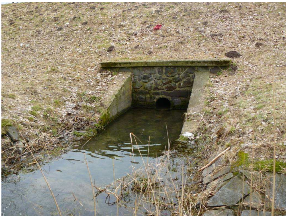
Obrázek 7: Odpad od pravého požeráku (Kebrlová 2011)
