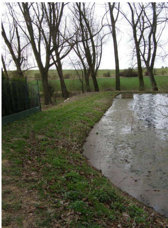
Obrázek 3: Čelní hráz a požerák na jaře (Kebřlová, 2011)
