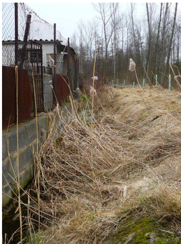
Obrázek 9: Odpad od levého požeráku, který slouží zároveň k napouštění Červeného rybníka (Kebrlová 2011)
