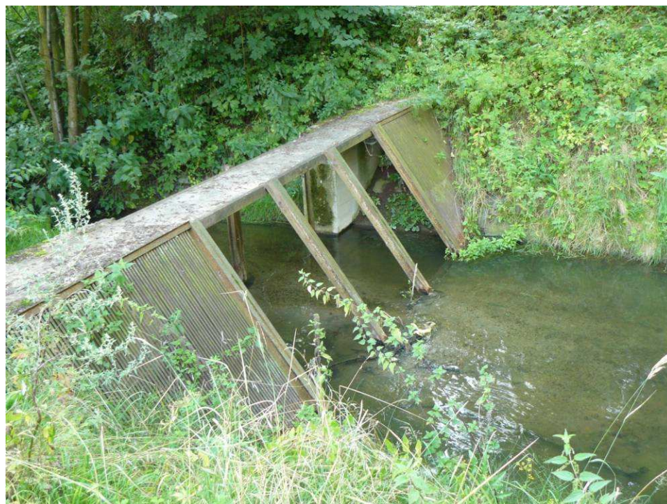
Obrázek 8: Česle na odpadu od výpusti (Kebrlová, 2010)
