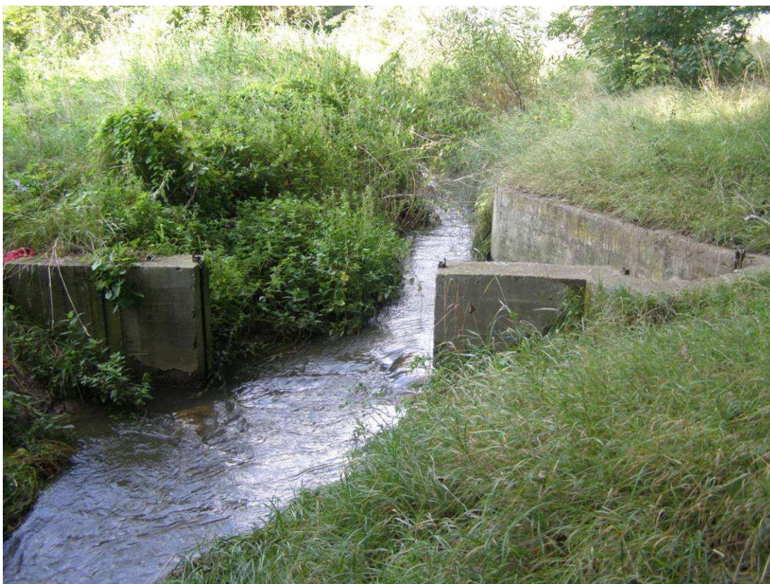
Obrázek 5: Rozdělovací objekt na Červeném potoce (Kebřlová, 2010)
