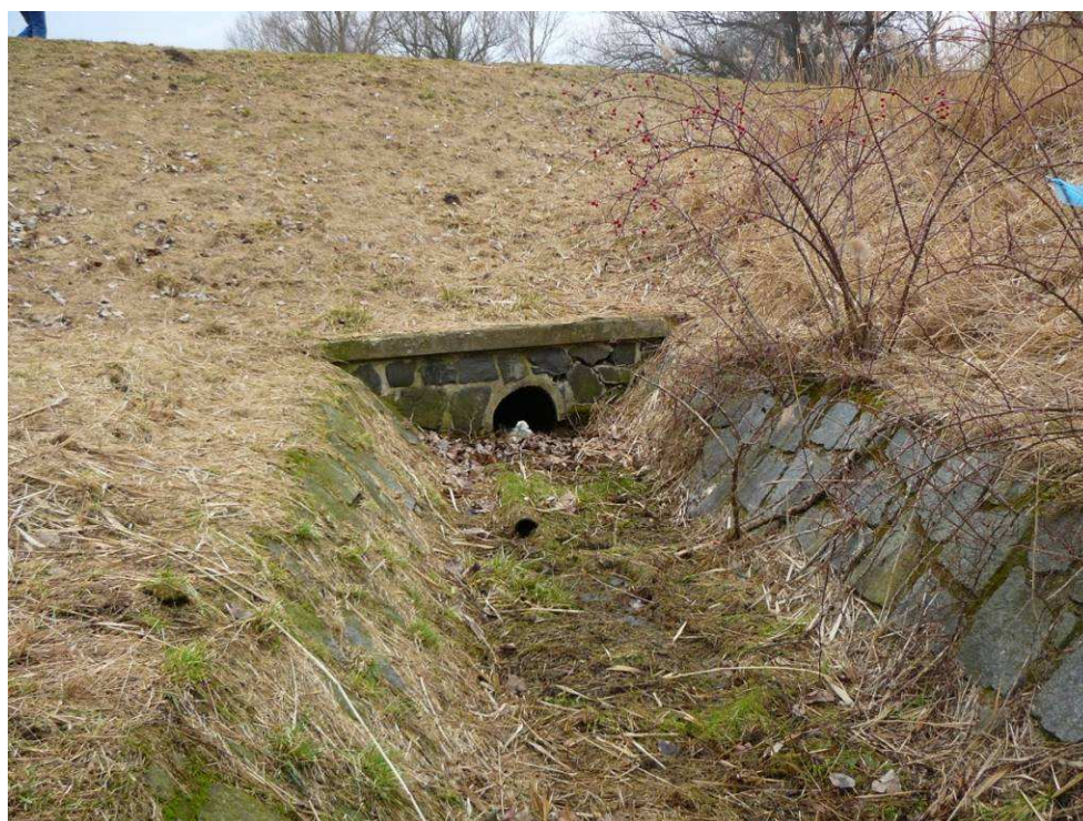
Obrázek 8: Odpad od levého, nefunkčního požeráku (Kebrlová 2011)
