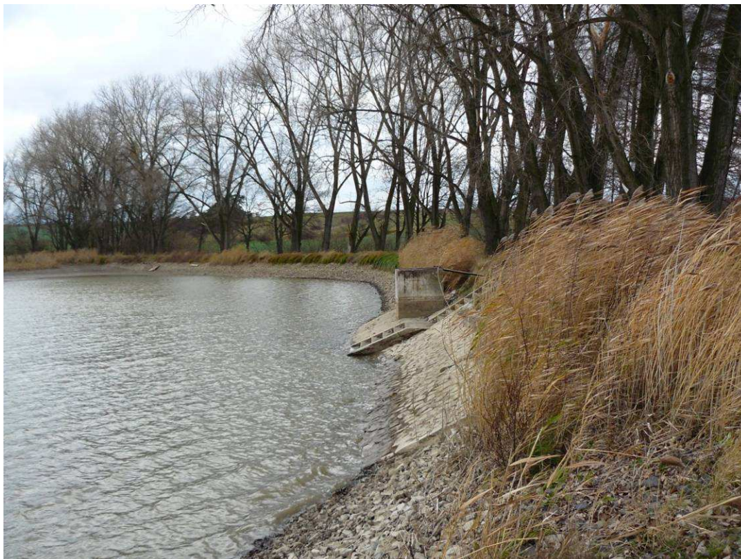
Obrázek 2: Pohled na boční hráz a požerák (Kebrlová, 2010)
