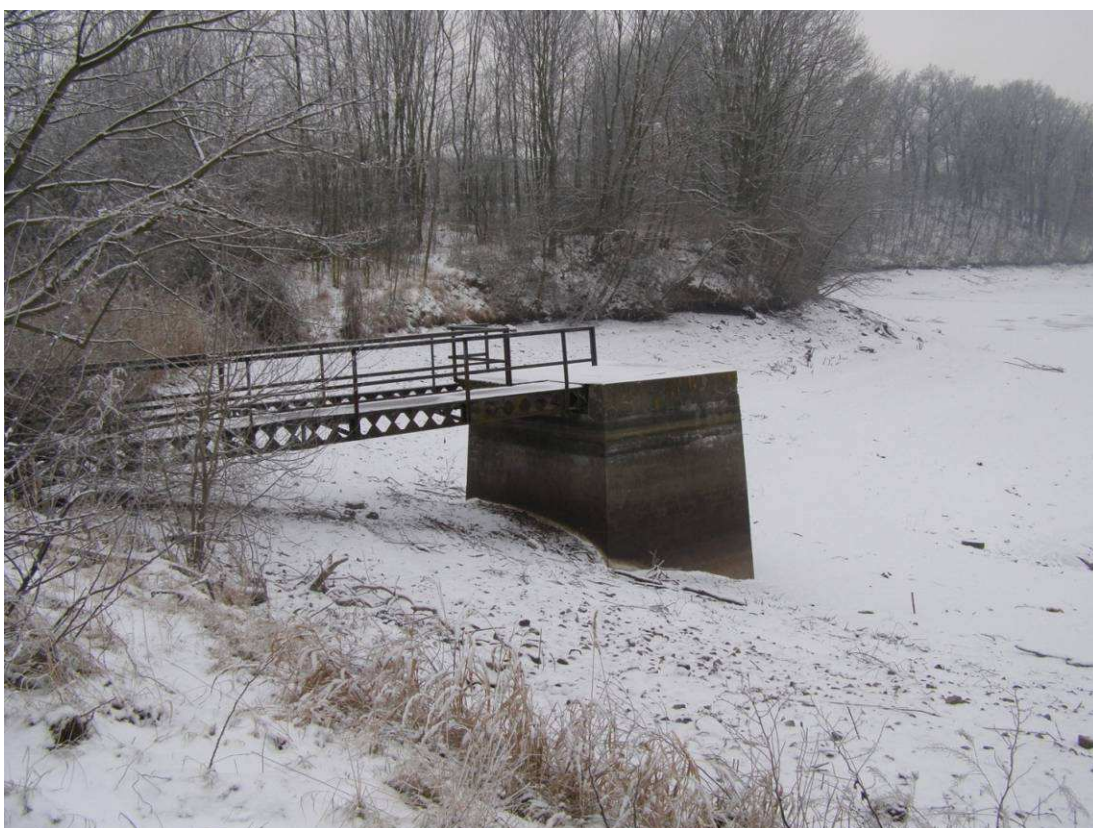
Obrázek 4: Šoupátkové vypouštěcí zařízení (Kebrlová, 2009)
