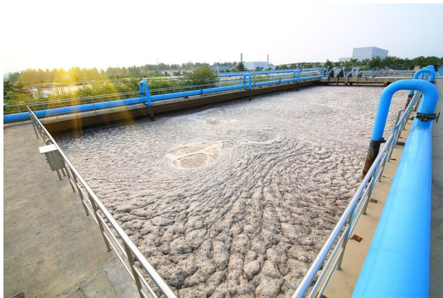
Obr. 2.9: Anaerobní vodní prostředí, čistírenský kal [31]
