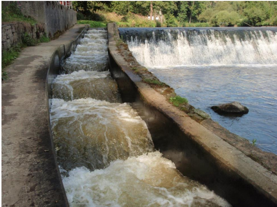
Obrázek 25 : rybí přechod na Horním jezu v Lokti nad Ohří
