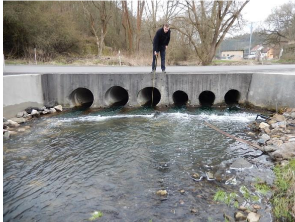
Obr. č. 14: Propustky pod silnicí v obci Hředle
