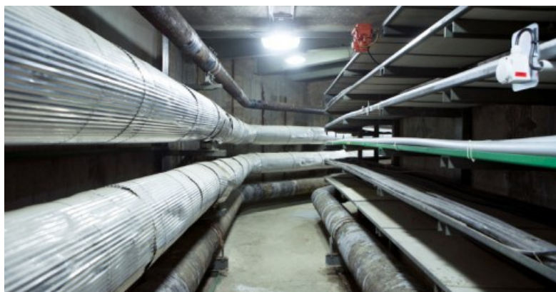
Obr. 1.2 Uložení potrubí do země s ochranným tělesem
