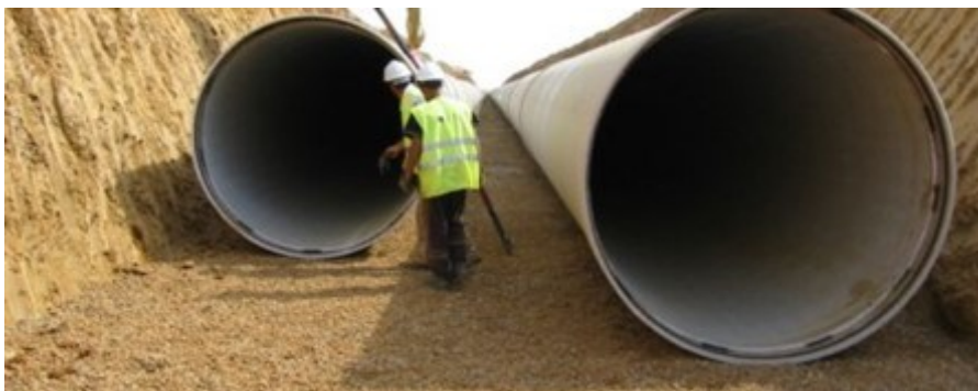
Obr. 1.20 Ukládání potrubí do výkopu
