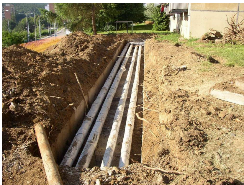
Obr. 1.1 Prosté uložení potrubí do země
