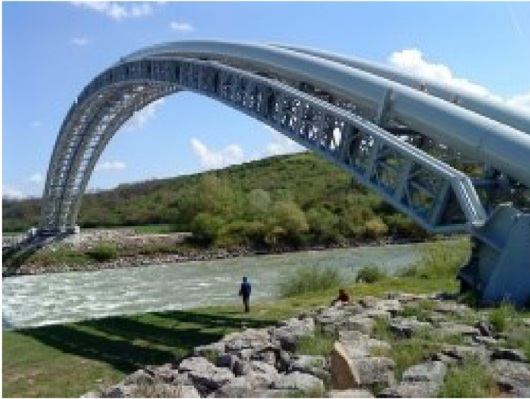
Obr. 1.3 Uložení v nadzemní trase (plynovod)
