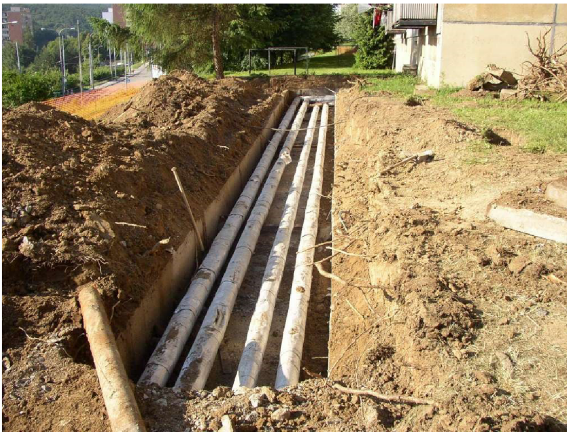
Obr. 1.1 Prosté uložení potrubí do země
