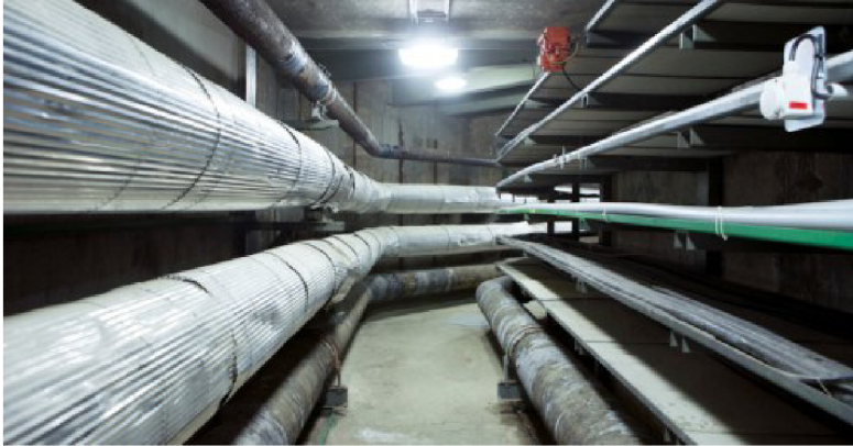
Obr. 1.2 Uložení potrubí do země s ochranným tělesem
