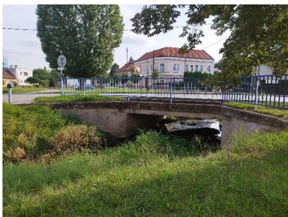
Obr 31. Silniční most ve Svitávce (P. Řezníková, 2022)
