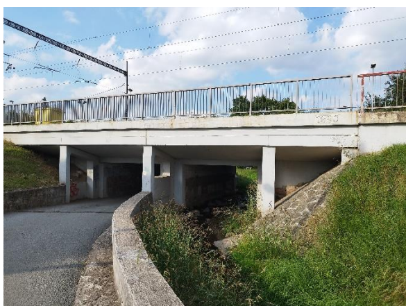
Obr 33. Železniční most ve Svitávce (P. Řezníková, 2022)
