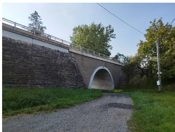
Obr 32. Silniční most na Vaculce (P. Řezníková, 2022)
