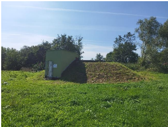
Obr 37. Zemní vodojem v Sebranicích (P. Řezníková, 2022)
