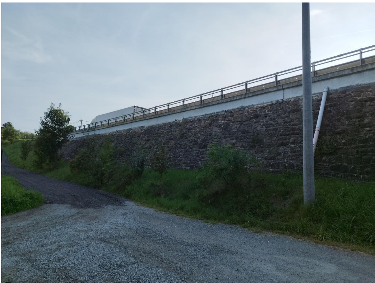
Obr 11: Silniční násep zpevněný kamenem v obci Sebranice (P. Řezníková, 2022)
