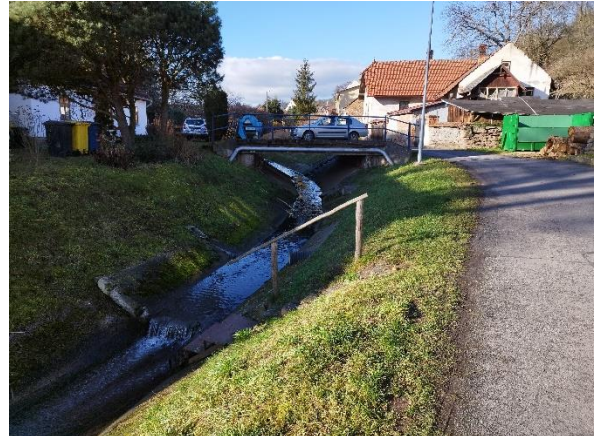
Obr 48. Upravené koryto Sebránku v Sebranicích (P. Řezníková, 2022)
