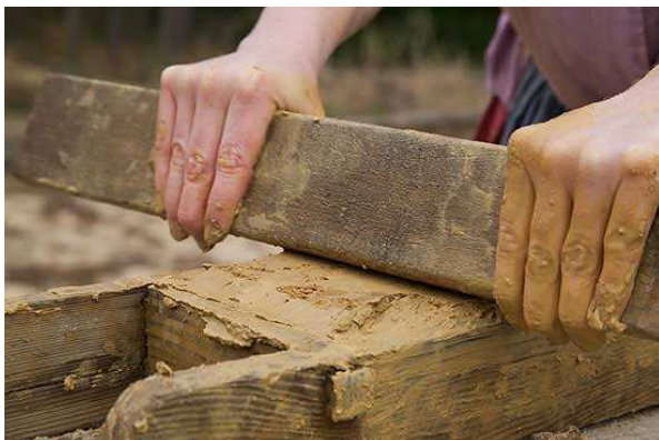
Obr 2. 6 Zarovnávání vyplněné formy s okrajem [24]
