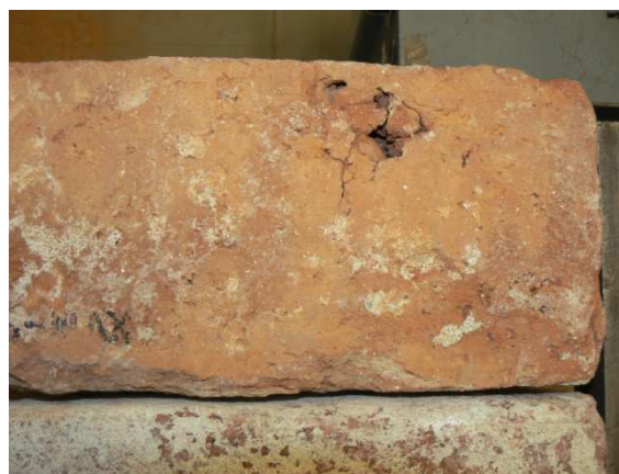
Obr 3. 18 Detail trhliny vzniklé při výpalu cihly
