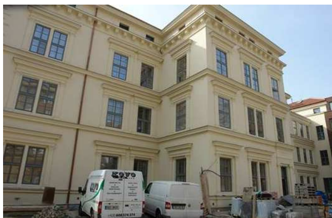
Obr 3. 7 Zrekonstruovaná budova A [23]
