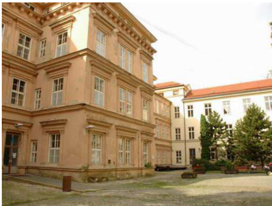
Obr 3. 1 Pohled na budovu A a B [23]
