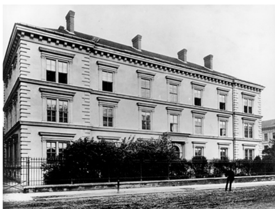
Obr 3. 6 Budova sirotčince okolo roku 1900 [22]
