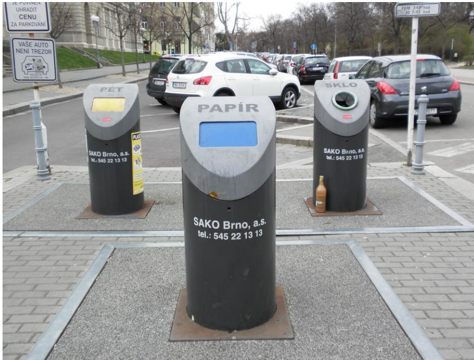
Obr. 39: Podzemní kontejnery na Malinovském náměstí
