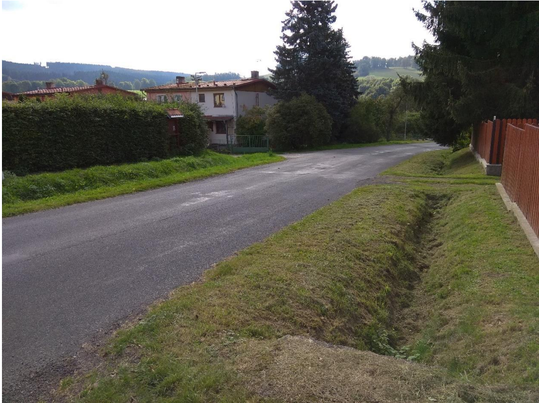
Obrázek 29: Odvodnění páteřní komunikace obce otevřeným příkopem se zásakem (Vlastní foto, 2021)
