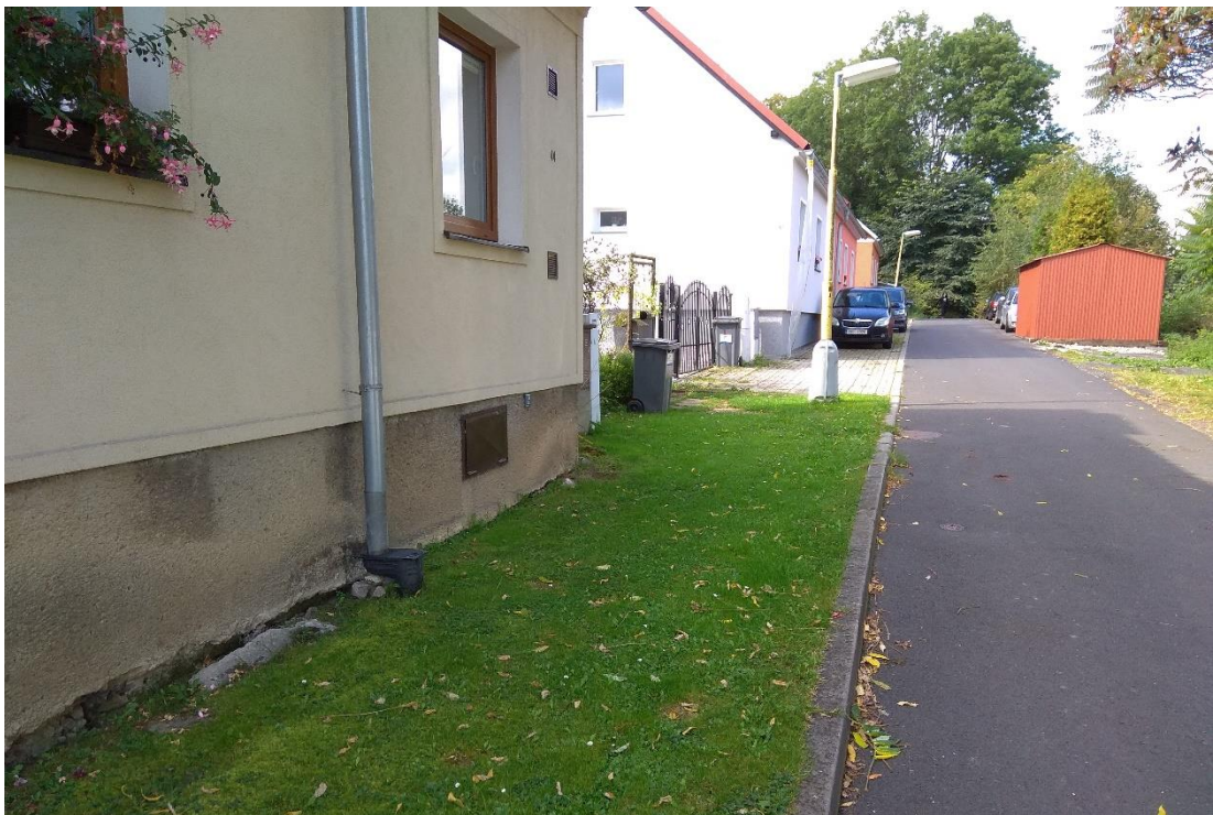
Obrázek 27: Odvodnění ploch střech do drenážního systému (Vlastní foto, 2021)
