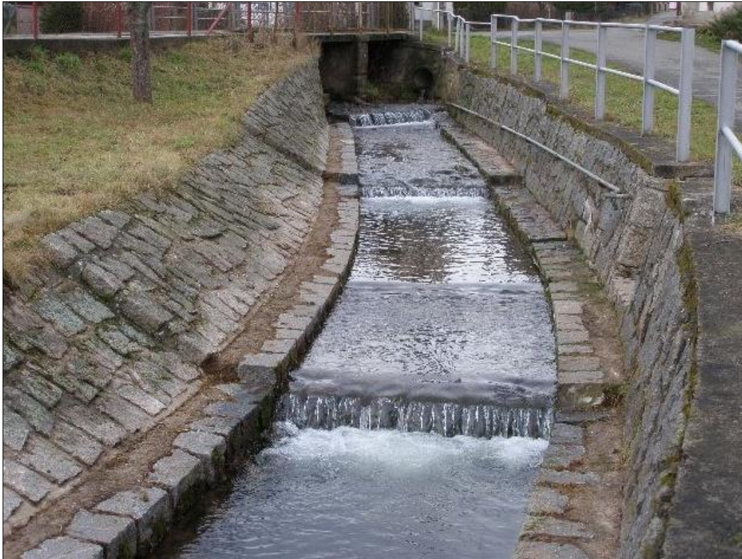
Obrázek 3: Regulovaný tok potoka v obci Velké Svatoňovice (Geocaching.com, 2015)
