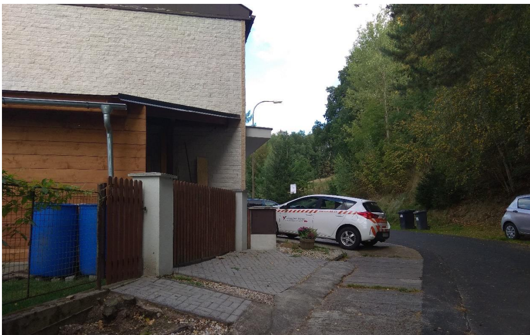
Obrázek 28: Odvodnění ploch střech do sudů k zálivce (Vlastní foto, 2021)
