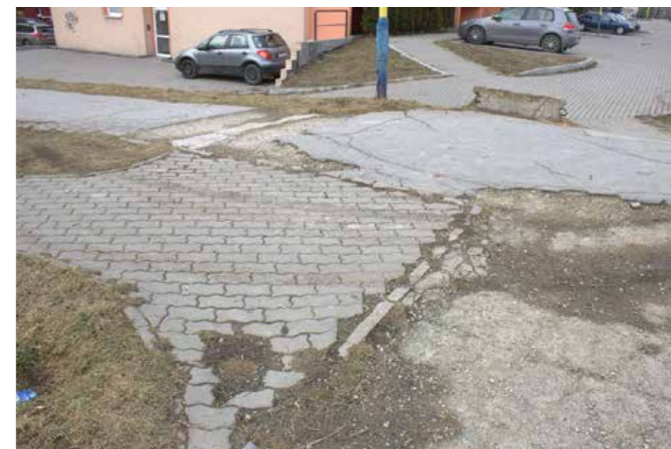
Obr. 36 Rozbitý a materiálovo nejednotný chodník
