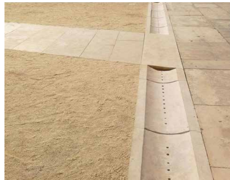
Obr. 43 Možný príklad zberného kanála na vodu vo verejnom priestore
