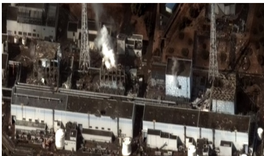
Obrázek 3: Poškozené budovy v jaderné elektrárně Fukušima I.
