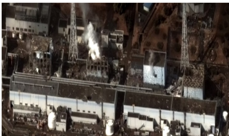
Obrázek 3: Poškozené budovy v jaderné elektrárně Fukušima I.
