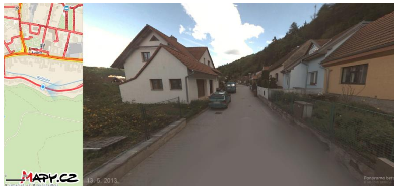
Obr. 7 Místní komunikace Podhoří, Kuřim - průjezdný profil
