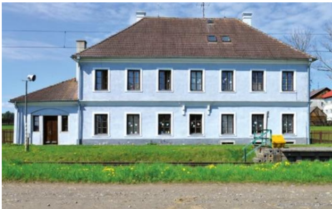
Obrázek 6: Bujanovská stanice, pohled od východu, 2022
