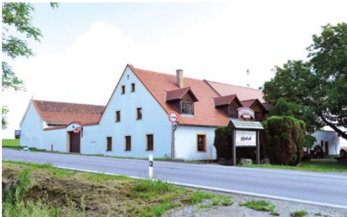
Obrázek 5: Pohled na objekt tzv. „kočárovny“ z jihu, 2022
