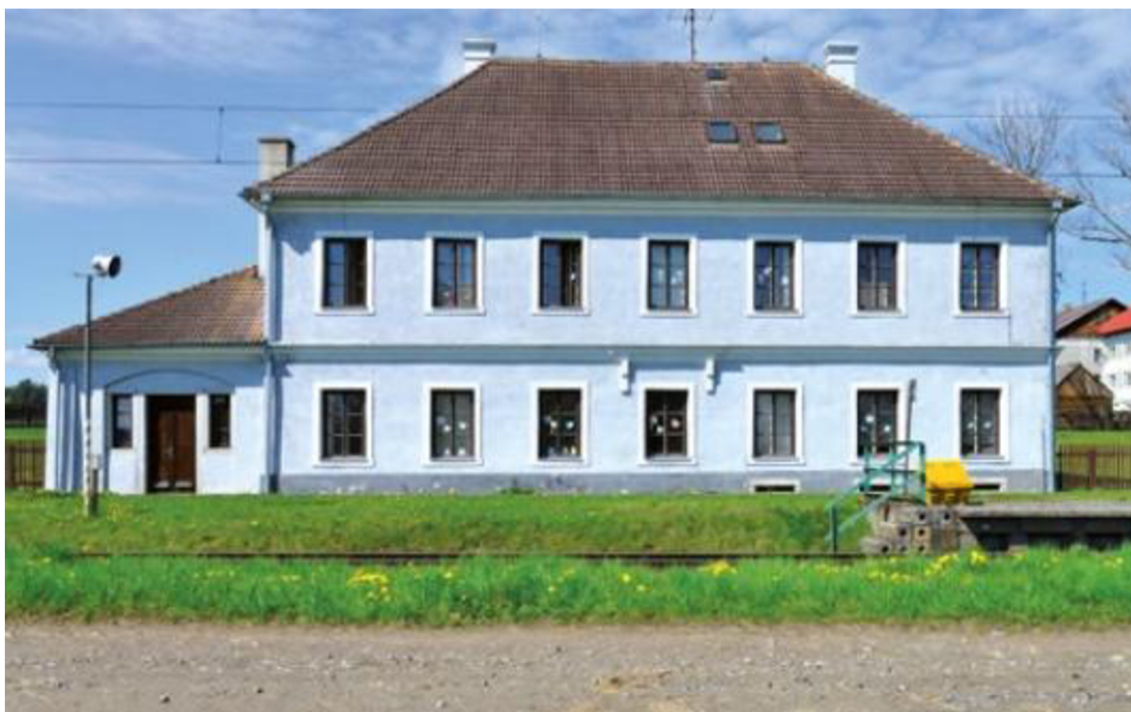
Obrázek 6: Bujanovská stanice, pohled od východu, 2022
