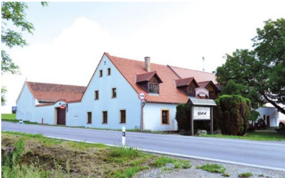
Obrázek 5: Pohled na objekt tzv. „kočárovny“ z jihu, 2022
