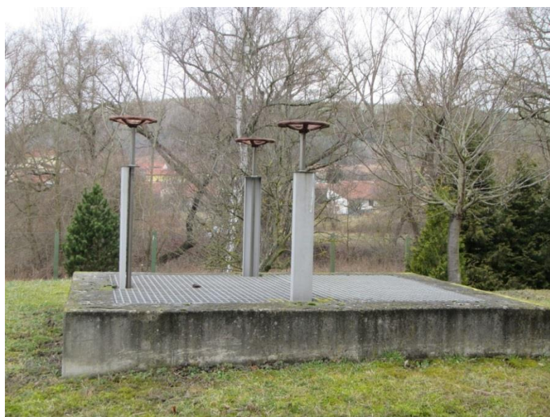
Obr. 10 Rozdělovací komora (autorka)
