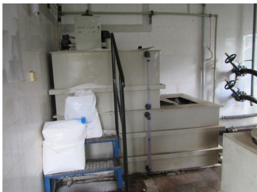
Obr. 19 Dávkovací stanice flokulantu (autorka)
