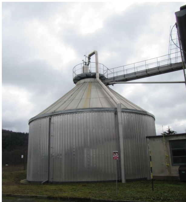
Obr. 16 Fermentační reaktor (autorka)
