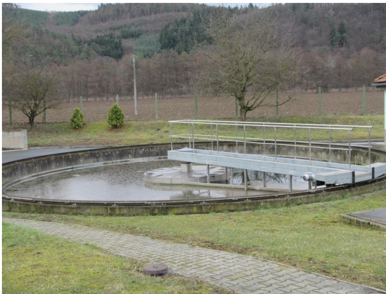
Obr. 13 Dosazovací nádrž (autorka)
