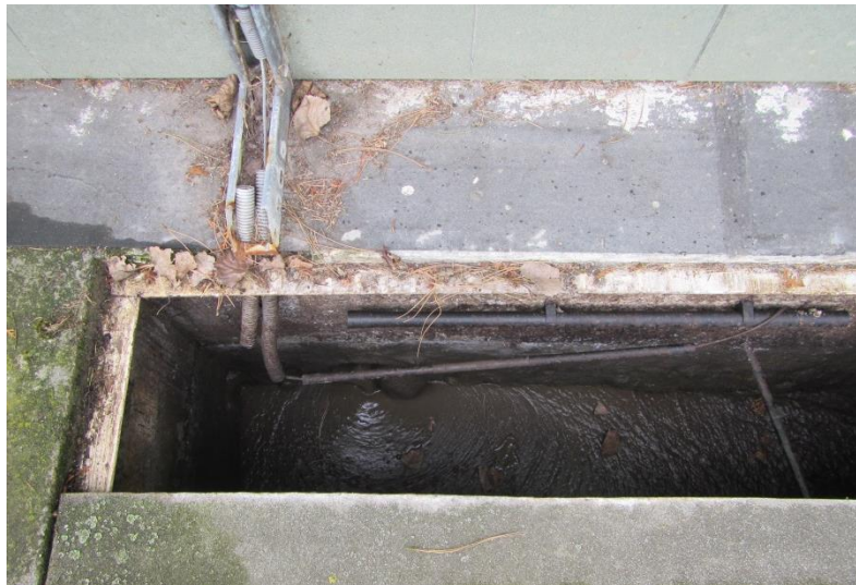
Obr. 15 Jímka zahuštěného kalu flotací (autorka)
